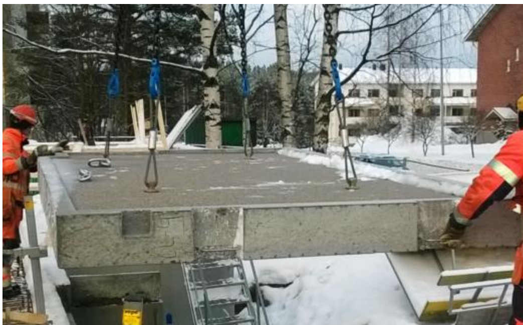
Kuva 4. (Kaikkonen 2016). Elementin asennus työmaolosuhteissa. (Kaikkonen 2016)
