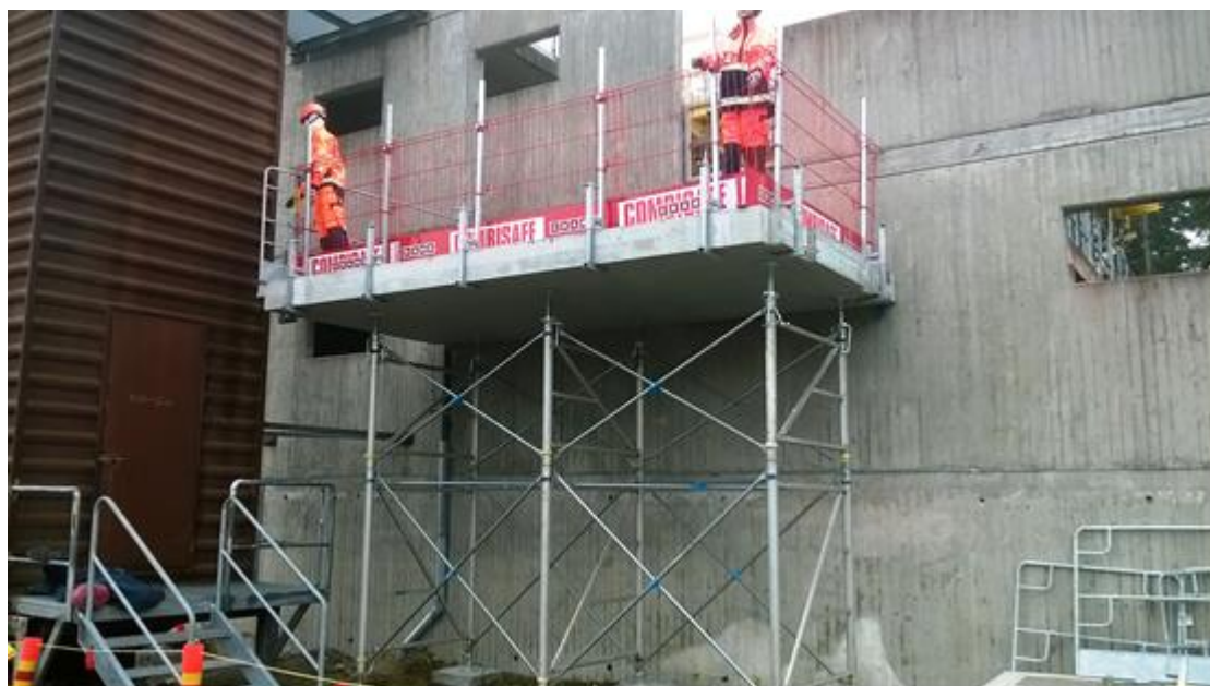
Kuva 3. Lemminkäinen Talo Oy:n parvekerasti viimeistelyvaiheessa. (Kaikkonen 2016)
