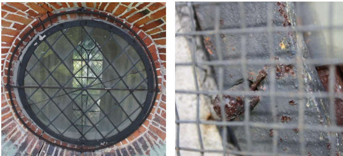
Kuva 19 ja 20. Kuvassa vasemmalla oven yläpuolinen ikkuna kokonaisuudessaan ja oikealla lattarautojen kiinnitys, jossa klemmari on korvattu ohuella naulalla.
