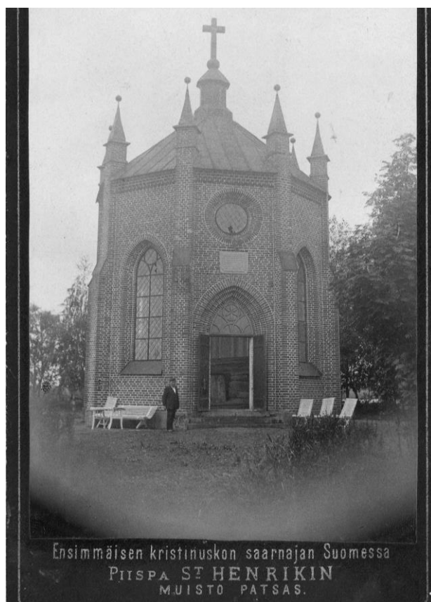
Kuva 8. Piispa Henrikin saarnahuoneen suojahuone, joka toteutui suunnitelmien mukaisesti kahdeksankulmaisena uusgoottilaisena tiilirakennuksena (kuva ProjekTila).
