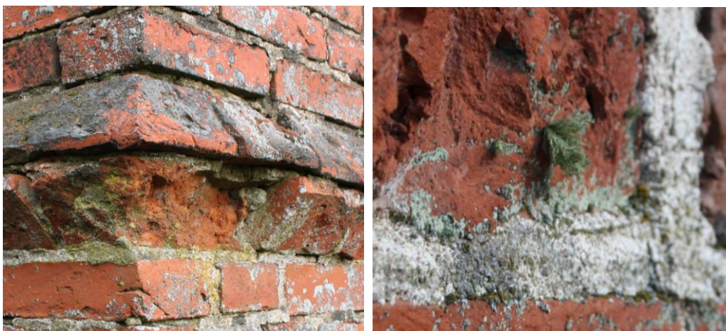
Kuva 4 ja 5. Vasemmalla tiilen pakkausrapautuma. Huokoinen tiili ja sateelle altis paikka yhdessä ovat rapautuman syynä. Oikealla näkyy orgaanista kasvustoa. Usein pohjoispuoliset osat kuivuvat hitaammin ja orgaaniset kasvustot viihtyvät näillä julkisivuilla.
