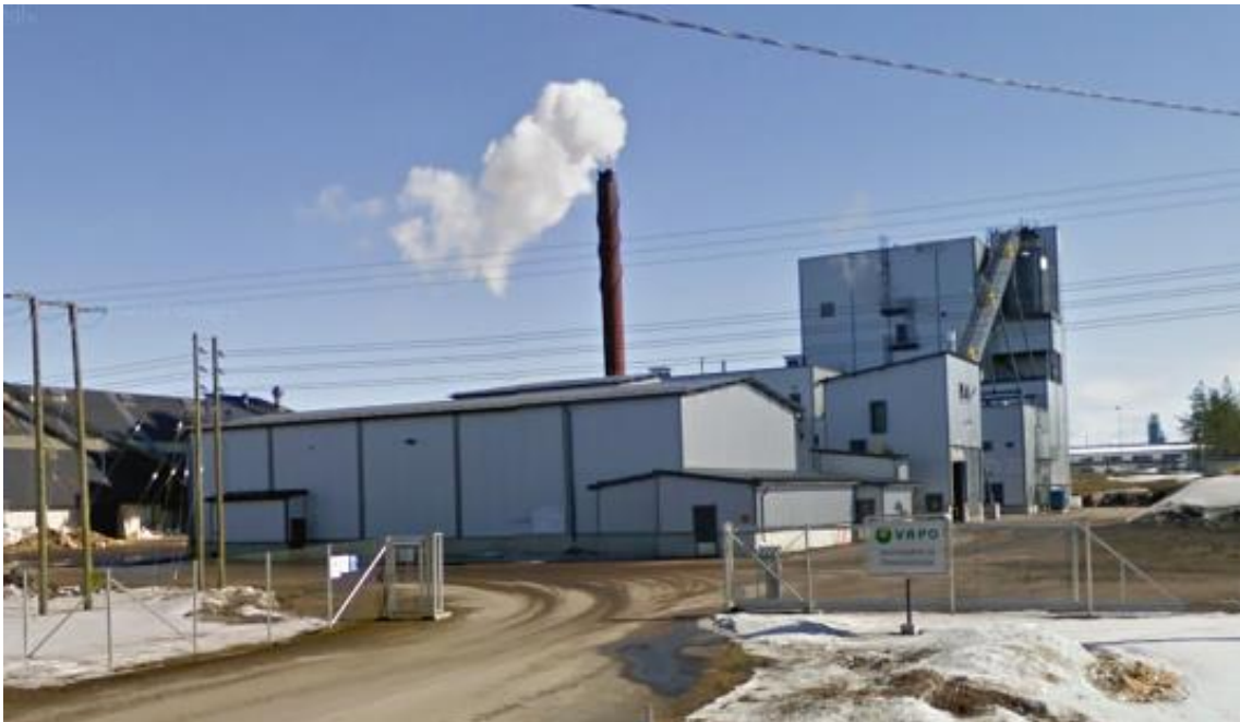
KUVA 2. Vapo Oy Haapaveden voimalaitos
