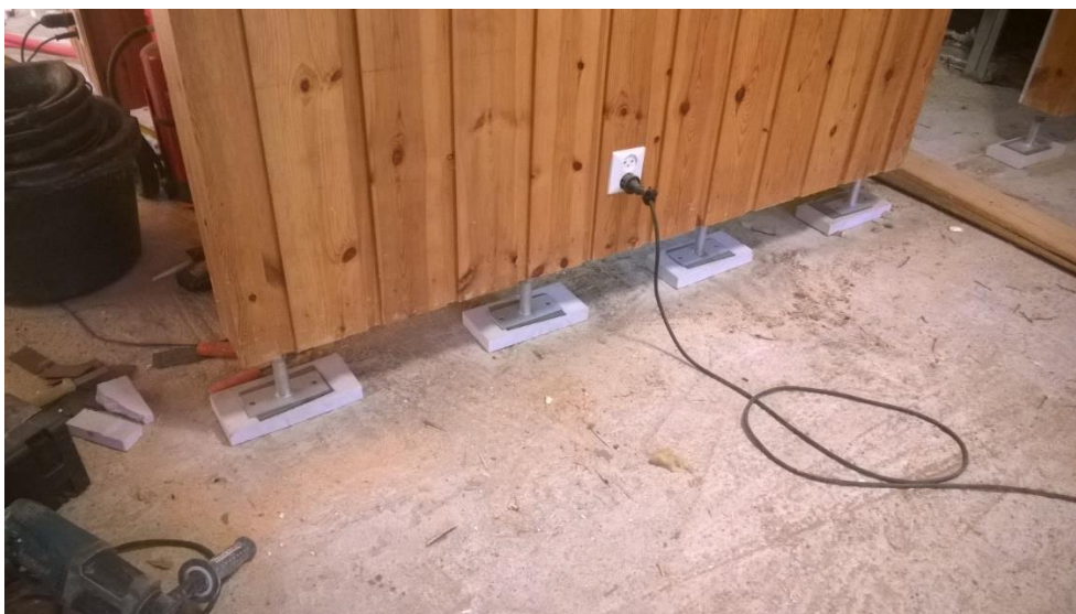
kuva 6. Väliseinien korottaminen säädettävillä pilarikengillä ja osatiilellä. (Korhonen 2015)
