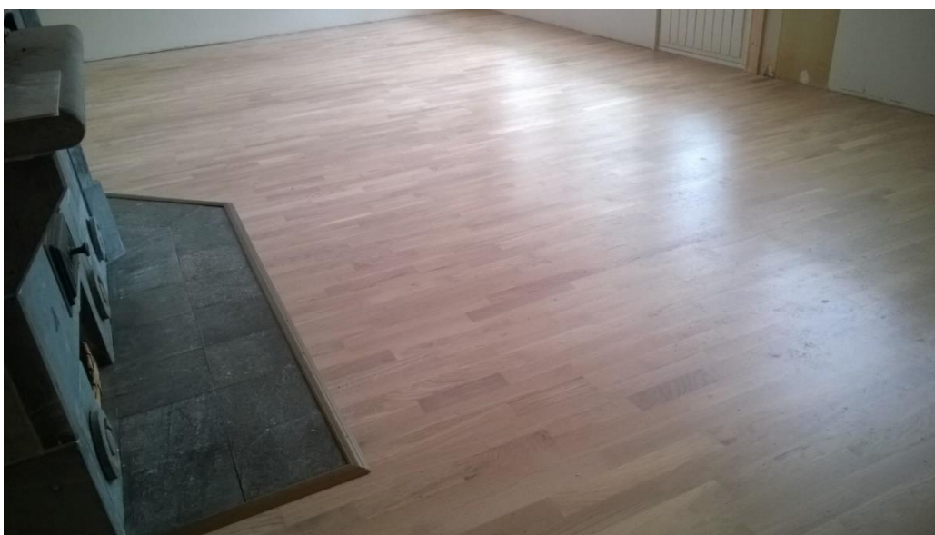
Kuva 10. Jalkalistojen asennusta vaille valmis lattia. (Korhonen 2016)
