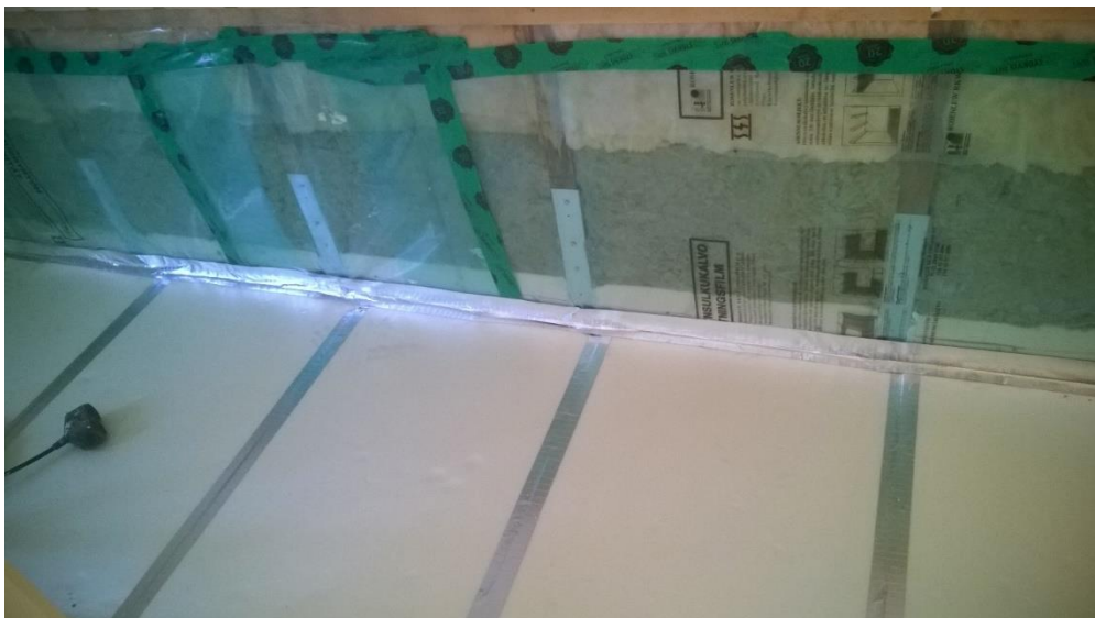
Kuva 7. Korjattu matalasokkeli Termokengällä ja -palkilla. Kuvassa näkyy myös uudet alapohjan eristeet. Finnfoam-eristeen saumat sekä seinän ja höyrysulun liitokset on teipattu alumiiniteipillä. (Korhonen 2015)
