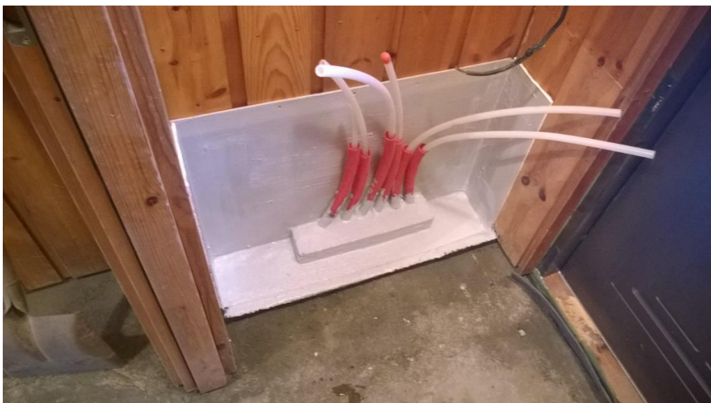
Kuva 9. Jakotukin kaukalo vedeneristettiin. Kaukaloon asennettiin lisäksi vuotohälytin vesivuotojen varalle. (Korhonen 2015)
