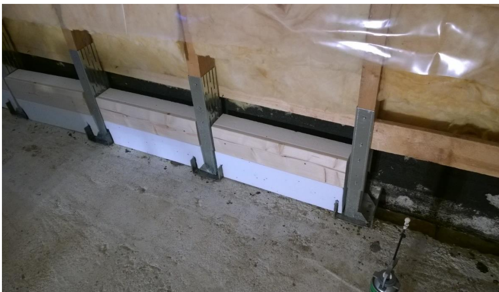
Kuva 4. Termokengän ja -palkin sovittaminen. U- palkit tukevat termokengän alapäätä. (Korhonen 2015)
