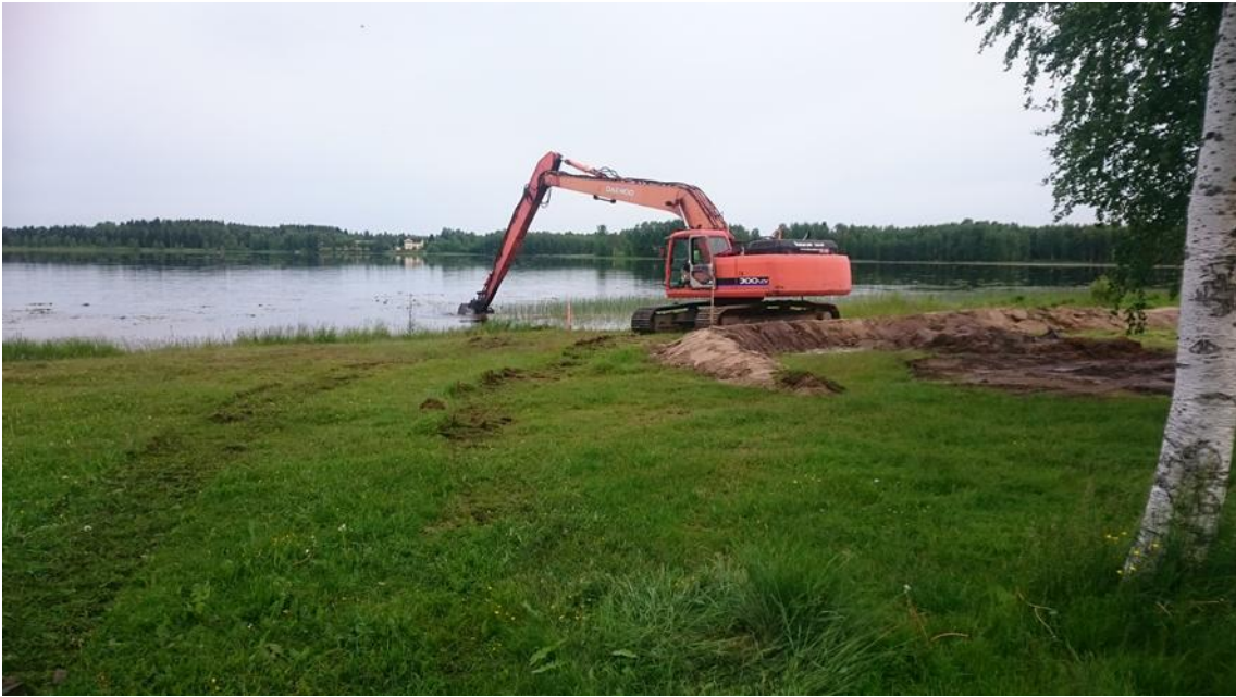
KUVA 17. Ruoppausmaat läjitettiin kuivumaan rannalle rakennettuun valumaaltaaseen (kuvassa koneen takana).
