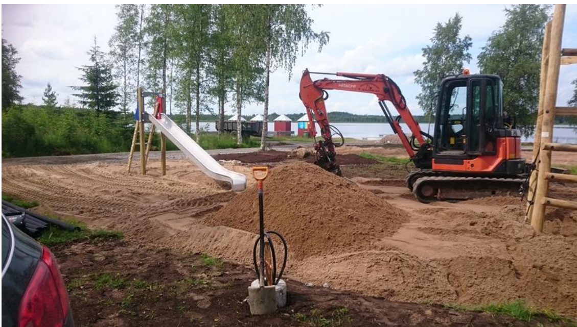
KUVA 13. Turvahiekat levitettiin laitteiden asennuksen jälkeen koneellisesti.
