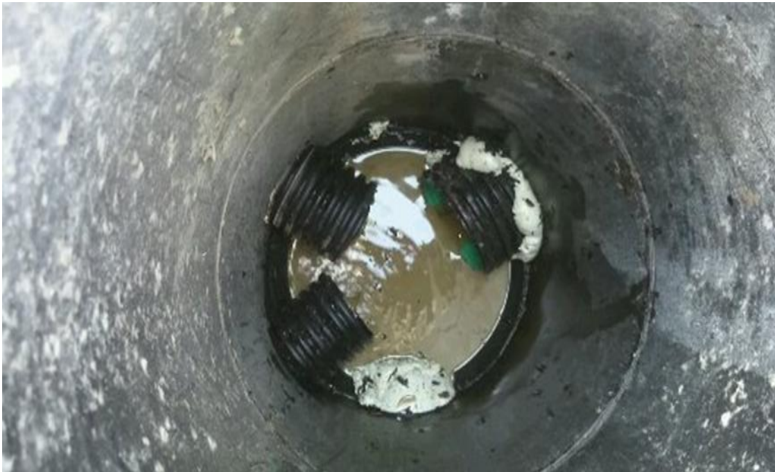
KUVA 9. Salaojakaivot tehtiin 315 mm:n rumpuputkesta ja putkitus 110 mm:n salaojaputkesta.
