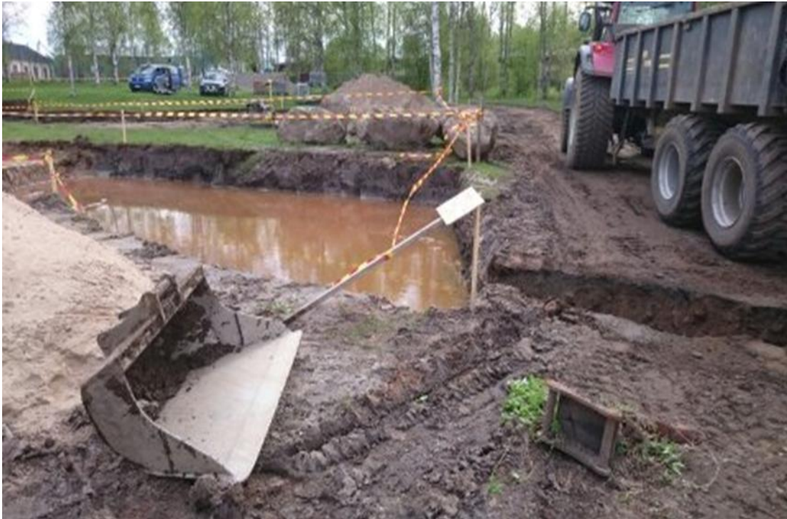
KUVA 5. Kaivanto täyttyy vedellä. Kaivantoja kuivatettiin kahdella uppopumpulla.
