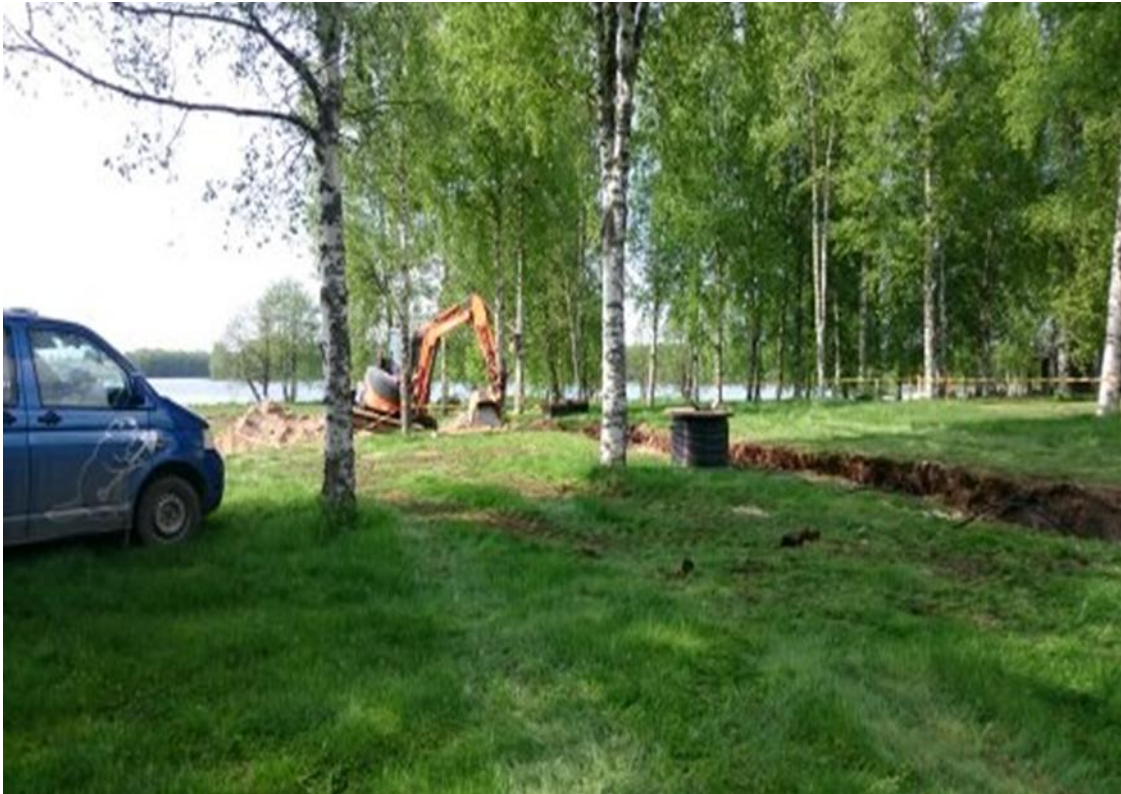
KUVA 16. Kaapelointeja alueella tehtiin yhteensä 250 metriä.
