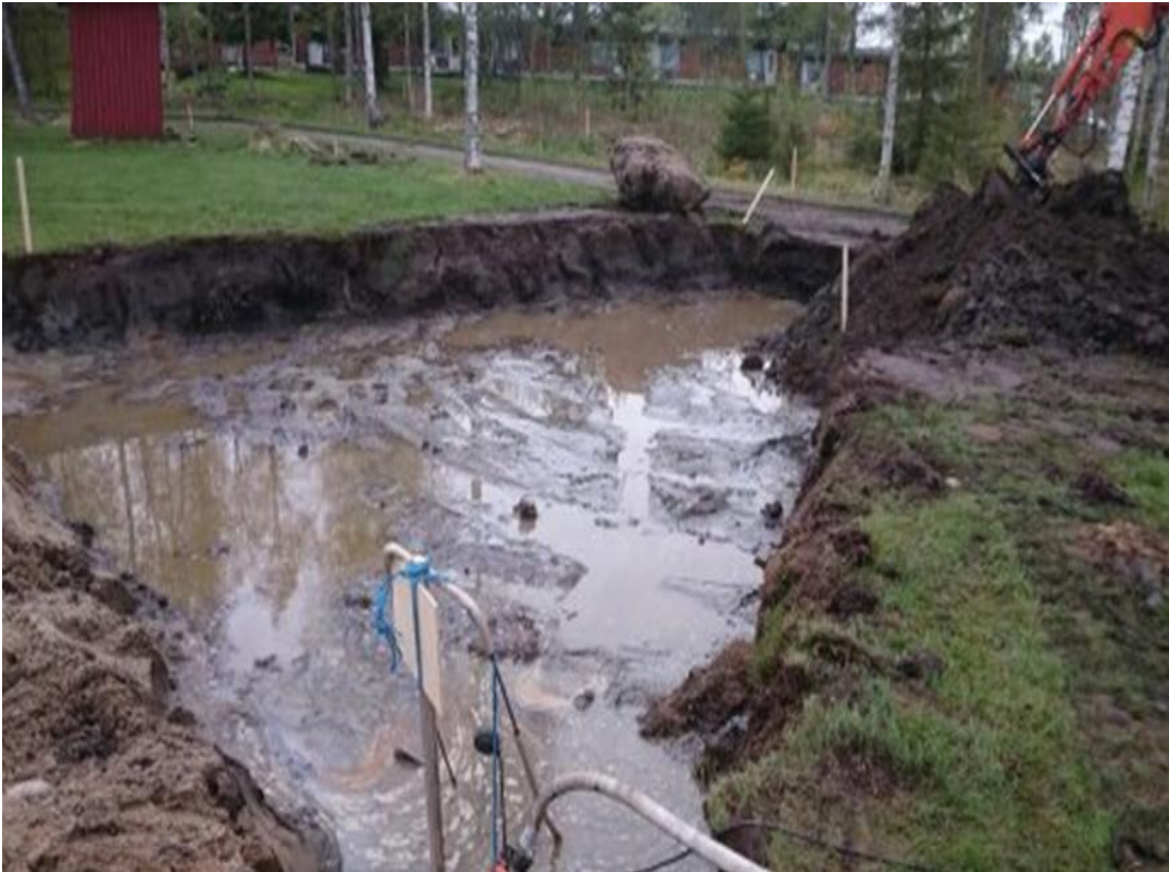
KUVA 8. Kaivannon vesien pumppaus on käynnissä. Vettä virtasi kaivantoon nopeasti. Kaivannon pohjalla sijaitti vettä läpäisemätön savikerros.
