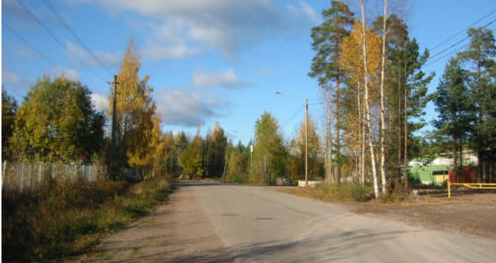
KUVIO 18 Koneharjunkadun vartta kulkevat sekä katuvalot että 20 kV:n sähkölinja.
