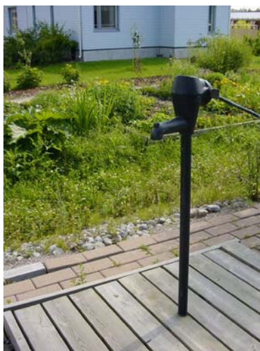
Kuva 17. Sadevesiä kerätään sadevesikaivoihin. (Kokkarinen. 2004)
