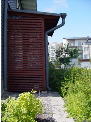
Kuva 21. Kattovedet johdetaan syöksytorven kautta vesikouruun. (Kokkarinen. 2004)
