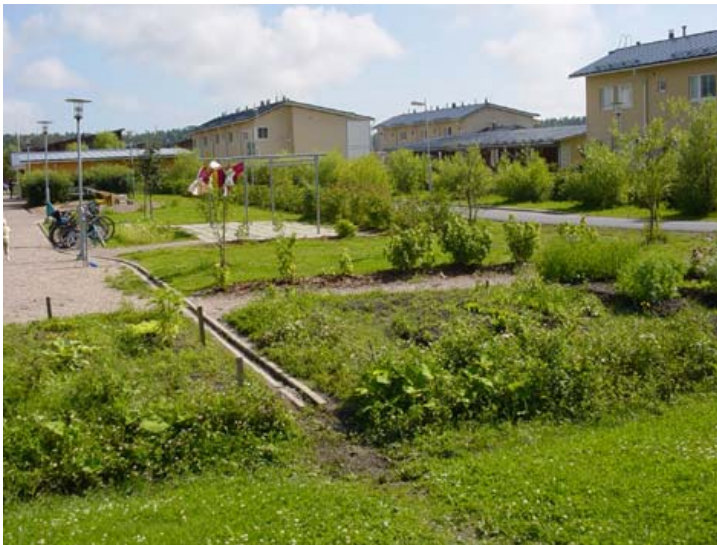
Kuva 18. Sadevedet johdetaan vihersormille. Pihojen pintamateriaalina on käytetty vettä läpäiseviä materiaaleja sekä kasvillisuutta. (Kokkarinen 2004)
