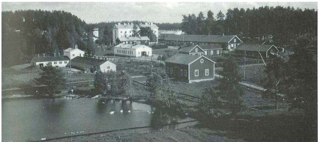
Kuva 23. Näkymä maaseutuopiston pihapiiristä kesällä 1939 ennen talvisotaa. Taustalla näkyy Paatelan suunnittelema oppilasasuntola, torpparintupa ja Krissin vanhan päärakennuksen tornia. Edustalla vanhoja, nykyisin jo purettuja rakennuksia. (Rauhakoski 1995, 35.)
