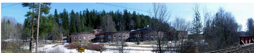
Kuva 31. Näkymä Ävikiin Krissin rautatiesillan tienoilta. Keskellä ns. "Käärmetalo", jonka takana pilkottaa punainen renkitupa.
