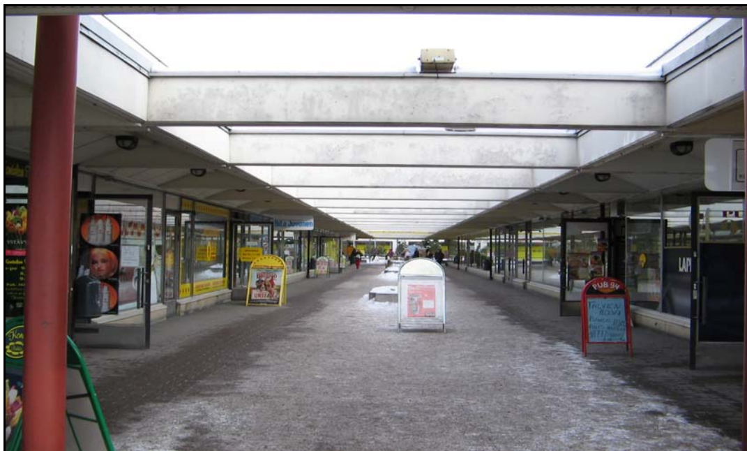
Kuva 4. Kontulan ostoskeskuksen käytävän kattorakenne
