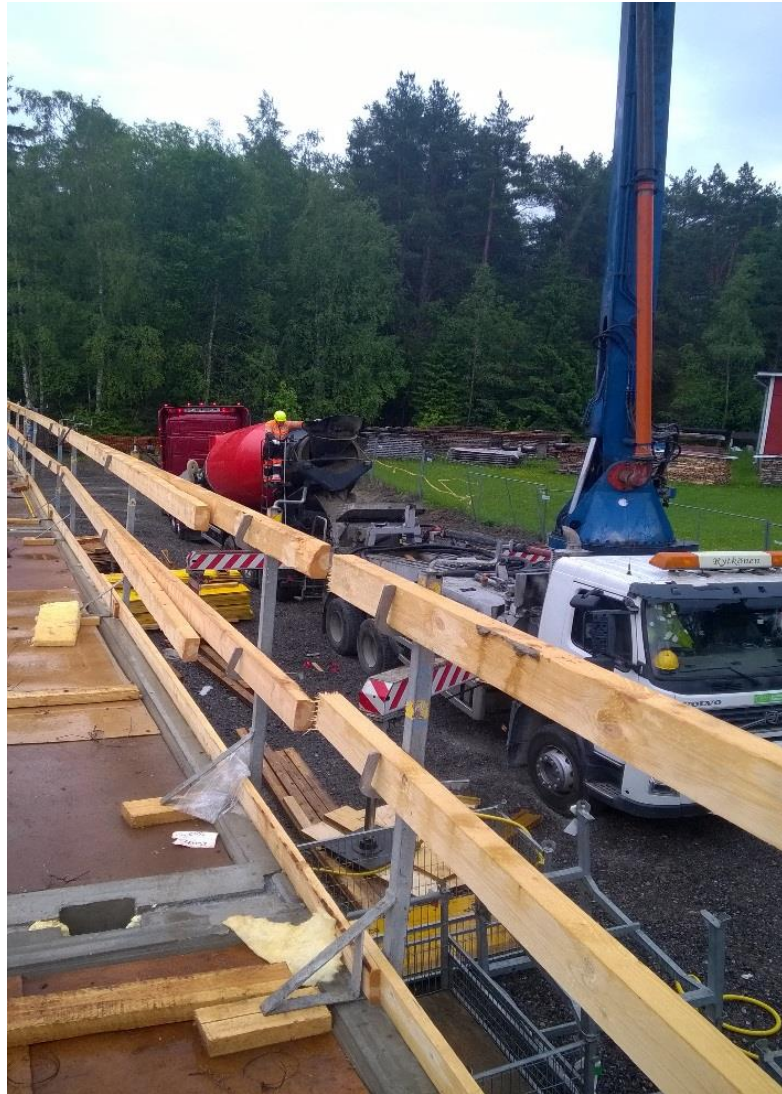
Kuva 6. Betonointikalusto vaati kantavan työmaatien sekä pystytyspaikan.
