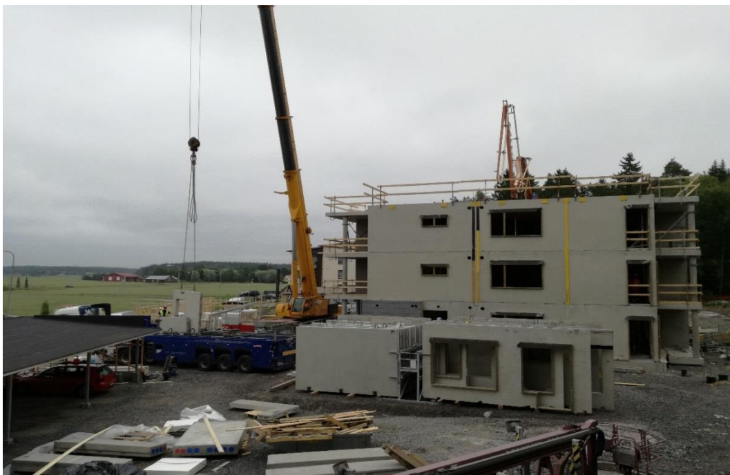
Kuva 3. Betonielementit varastoitiin elementtifakkeihin holvivalun aikana.
