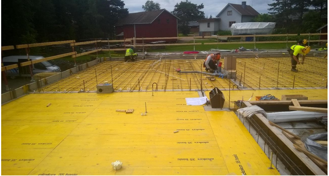
Kuva 2. Holvityövaiheessa on yhteensovittava jokaisen aliurakoitsijan työt toimivaksi kokonaisuudeksi.
