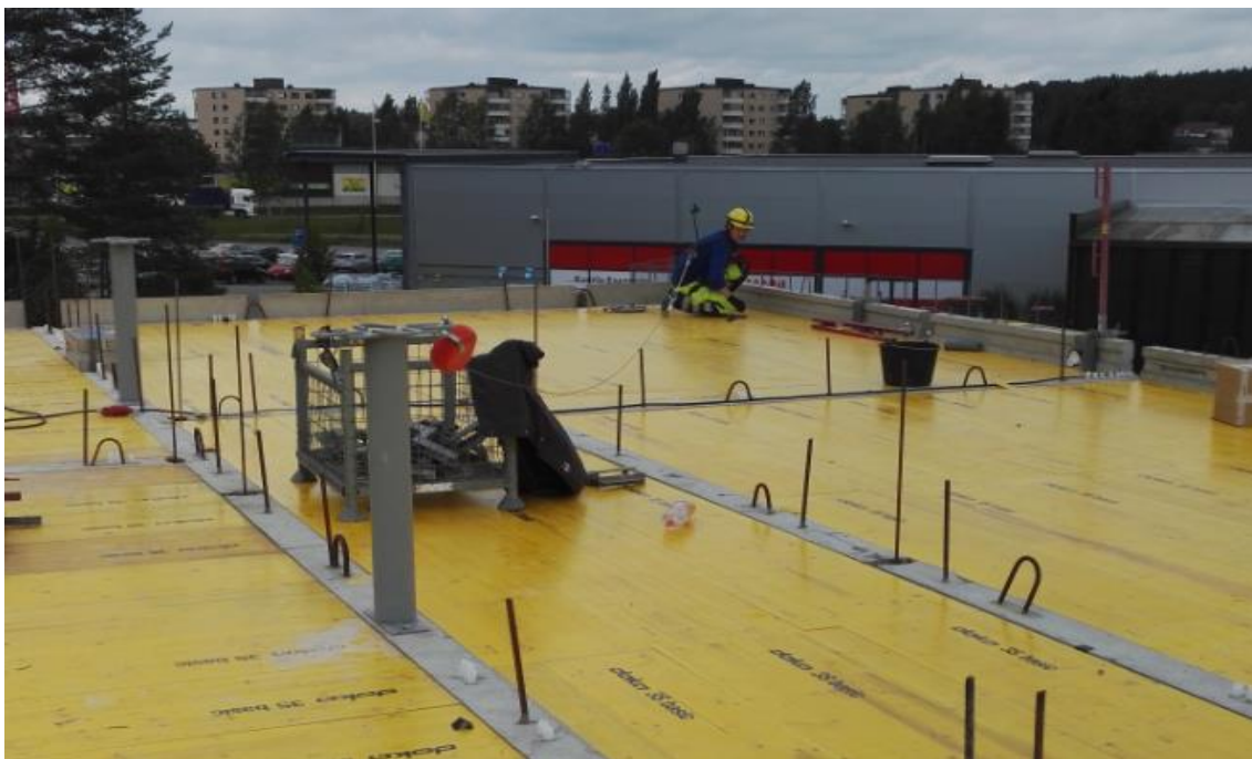
Kuva 5. Holvinputoamissuojaus asennettiin käyttäen valjaita.
