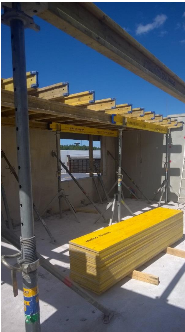
Kuva 4. Doka-holvimuottikalusto.
