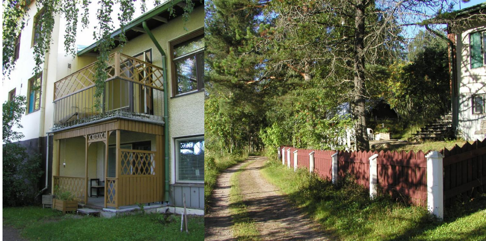
KUVIO 13. Uusia puisia rakenteita, jotka eivät sovi rakennuksen tyyliin.
