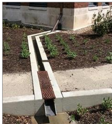
Kuva 26. Kattovedet voi ohjata erilaisilla kouruilla vaikka suoraan istutuksiin (Susdrain 2012 (vas.); Purdue Extension 2015 (oik.)).
