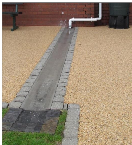
Kuva 26. Kattovedet voi ohjata erilaisilla kouruilla vaikka suoraan istutuksiin (Susdrain 2012 (vas.); Purdue Extension 2015 (oik.)).
