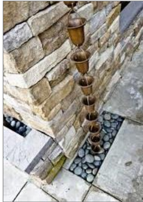
Kuva 25. Kuten syöksytorvenkin, myös sadevesikaivon voi korvata seinustalla johonkin mielenkiintoisempaan (AboutRainGardens.blogspot.fi 2012 (vas.); Rain-ChainsWorld.com 2016 (oik.)).
