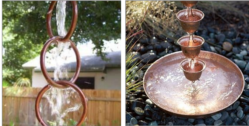
Kuva 22. Ketju toimii kuivalla säällä koristeena, mutta ohjaa veden maahan rännistä rannallakin sateella (Bestplants.com 2016).
