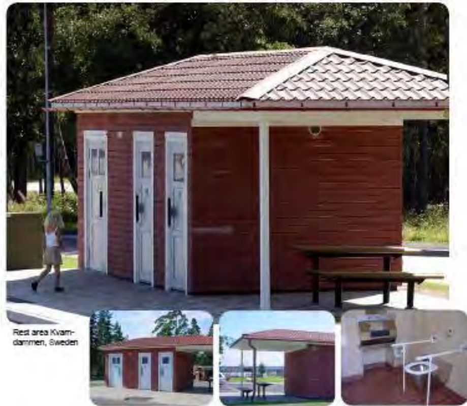
KUVA 30 Kuva wc-rakennuksesta, jonka sivussa on varjoisa katettu istuskeluryhmä. Rakennuksen suunnittelussa on huomioitu esteetömyys. Pukuhuone/WC tiloja sekä katosta voidaan muuttaa tarpeen mukaan. Käymälä voidaan liittää viemärointiin tai siihen voi asentaa kompostikäymälän. Lassila & Tikanoja, malli Tetracon.
