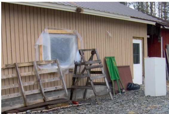
KUVA 3. Toimitilojen julkisivu rakennusvaiheessa (Rajamäki 2009)
