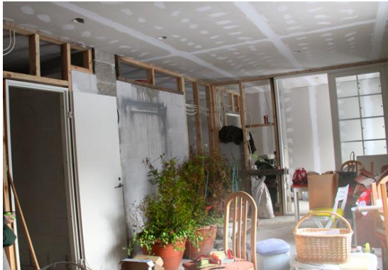
KUVA 11. Pannuhuoneen seinä ja pariovet
