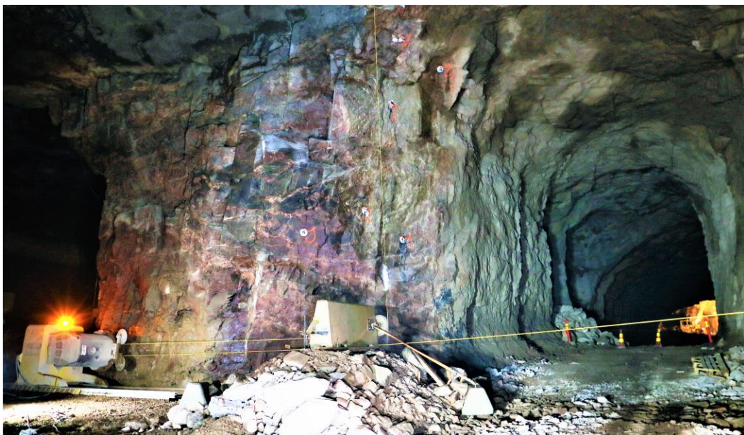
Kuva 15. Sahauskalusto asennettu tunneliin.
