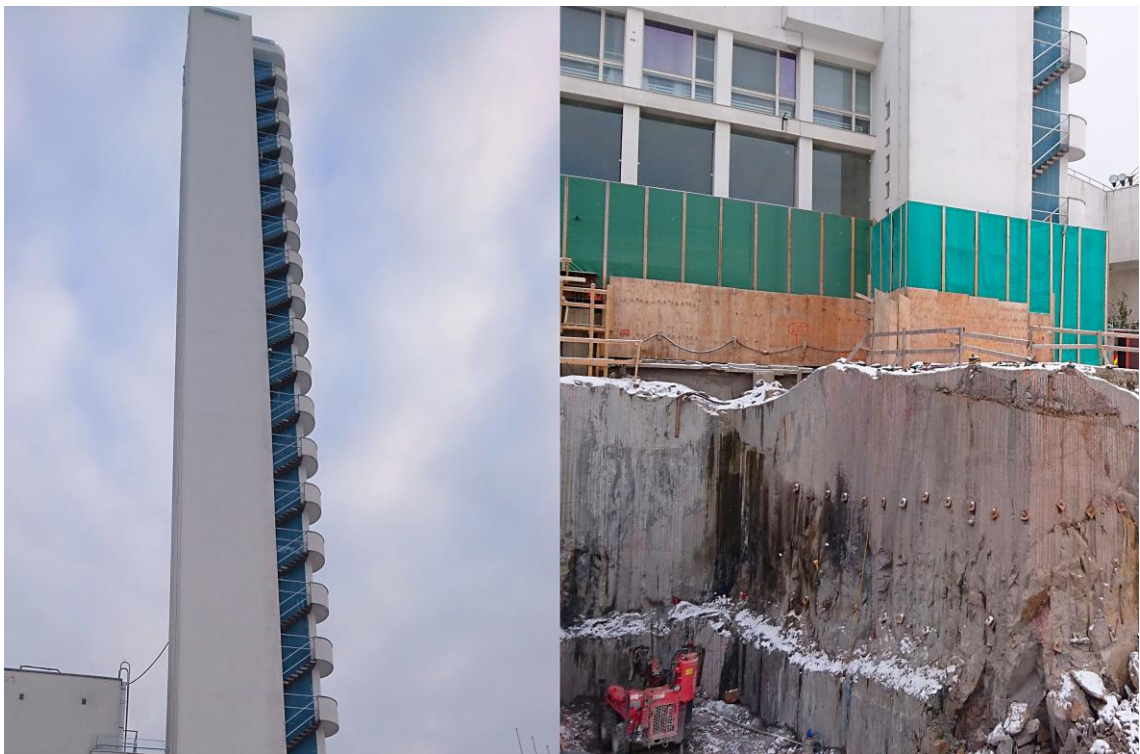
Kuva 10. Tornin aukiporaus ja lujitustyöt.
