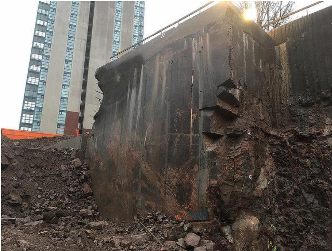
Kuva 14. Kivenlahti ylempi seinämä.
