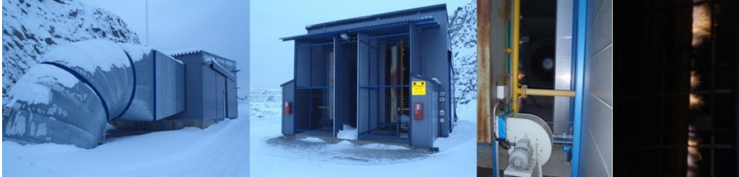
Kuva 7. Tuuletusasema (Kaivoksen ilmanvaihto 2013)
