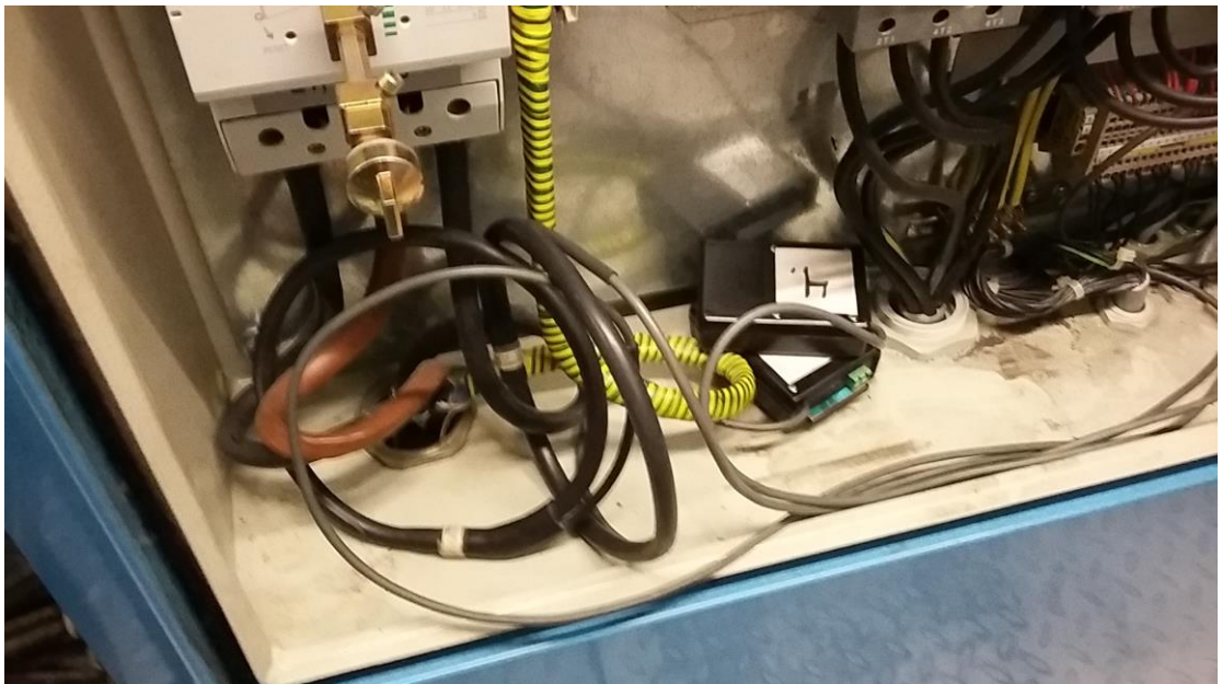
Kuva 12. Virtamittaus Boge B -kompressorissa
