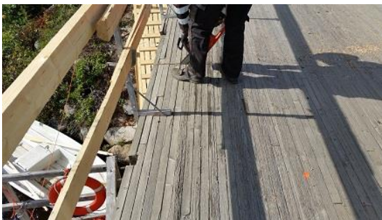
KUVA 9. Vanhan kansirakenteen katkaisu
