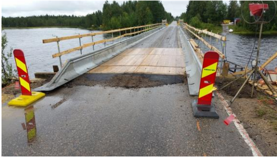
KUVA 22. Silta päivisin avoinna liikenteelle
