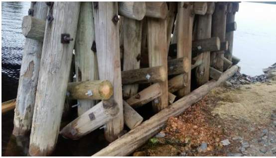
KUVA 30. Lisätyt vinotuet vanhojen yläpuolella
