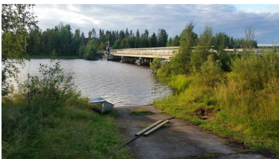
KUVA 4. Romppaisensalmen silta, Taivalkoski
