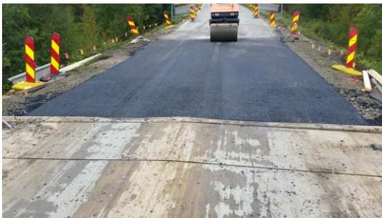
KUVA 28. Sillan päädyn päällyste
