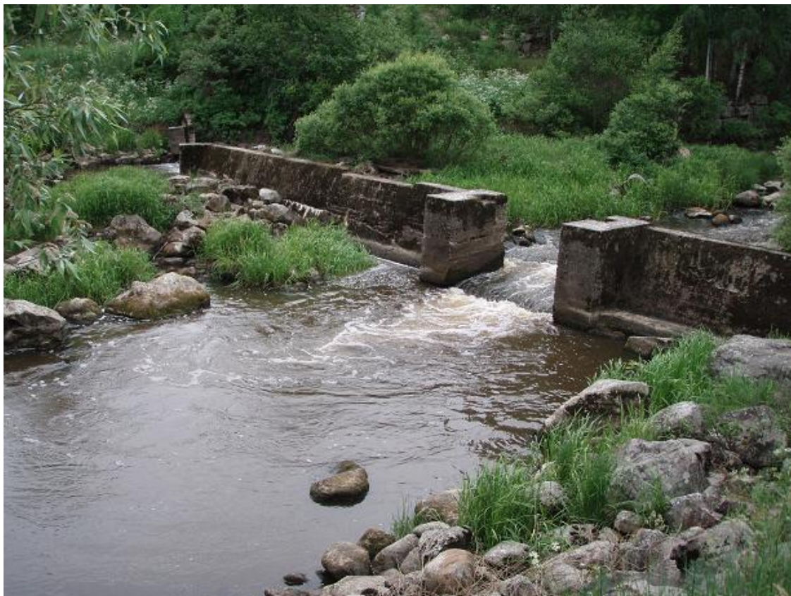
Kuva 12: Kosken keskivaiheilla oleva vanha patorakennelma.
