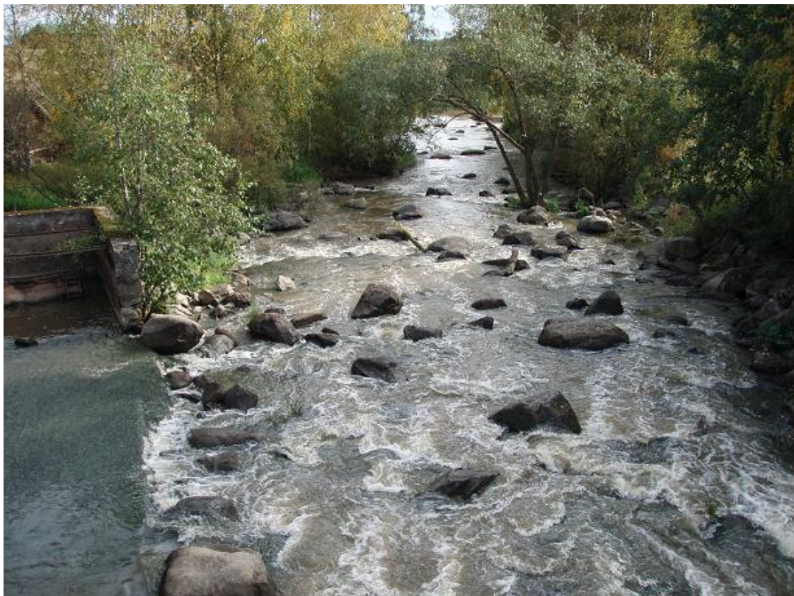
Kuva 4: Taipaleenkosken kuohuja sillasta alavirtaan.
