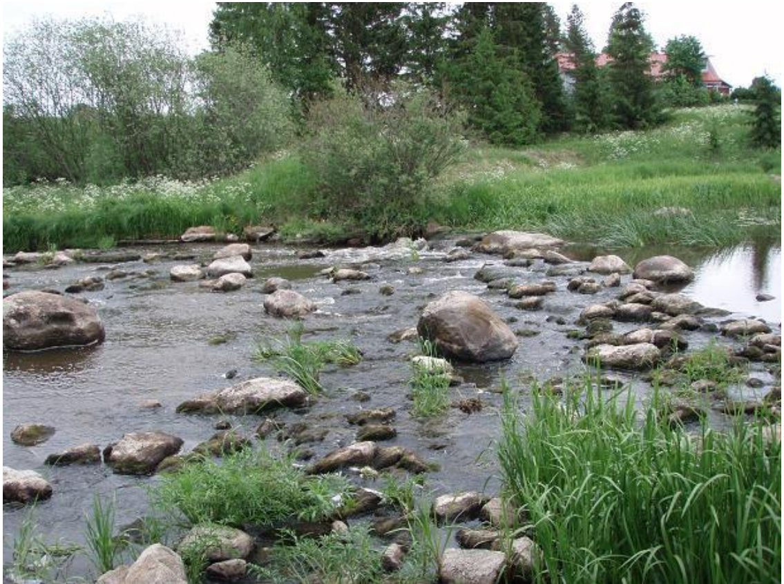
Kuva 9: Vanhan patorakennelman paikalle kivimateriaalista muotoiltu pohjapato.
