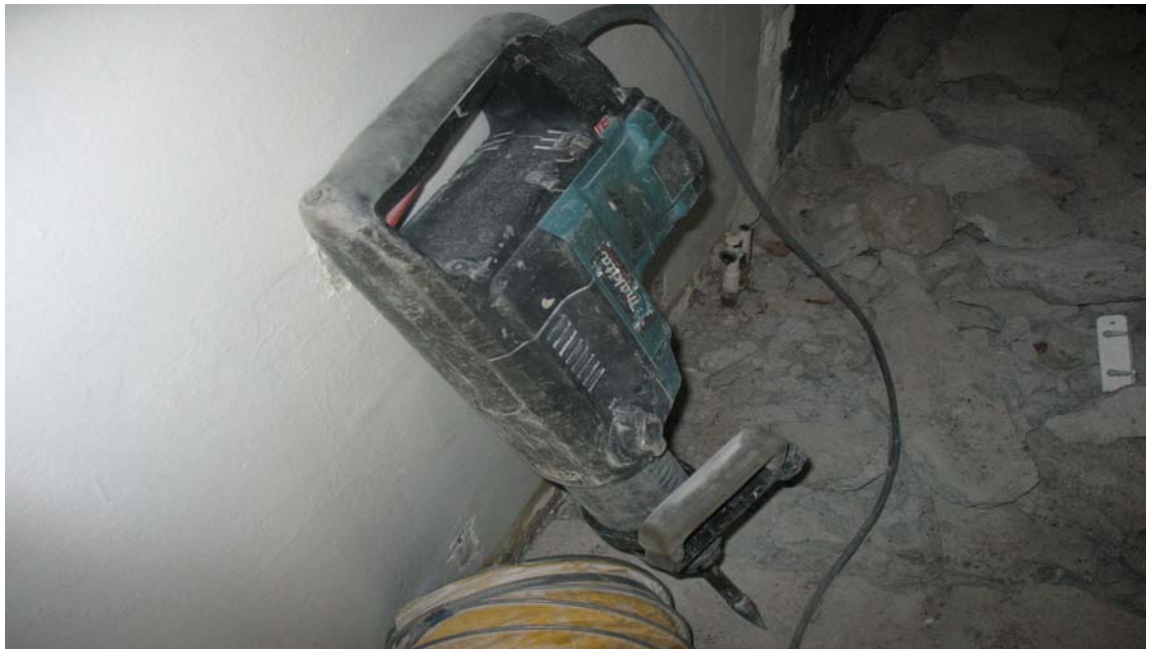
Kuva 6. Koneen rikkoontumisesta aiheutuva työvaiheen lisäaika TL3
