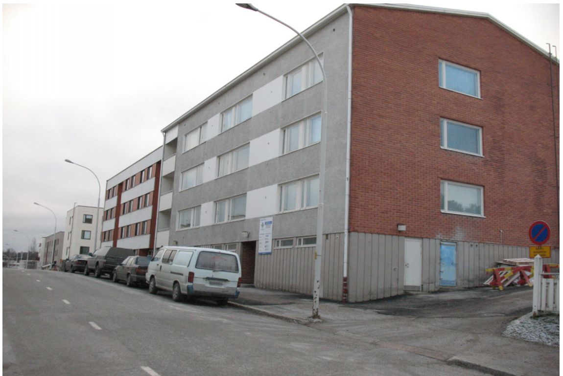
Kuva 15. Saneeraus- ja tutkimuskohde on vuonna 1960 valmistunut asuinkerrostalo.
