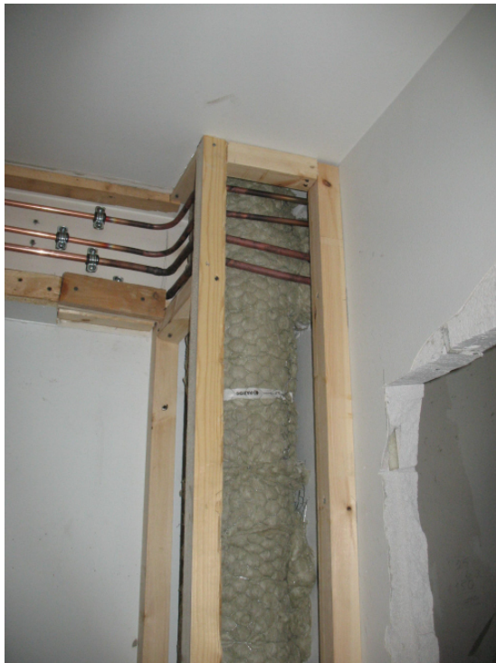
Kuva 20. Uusi eteisten viemärihormi
