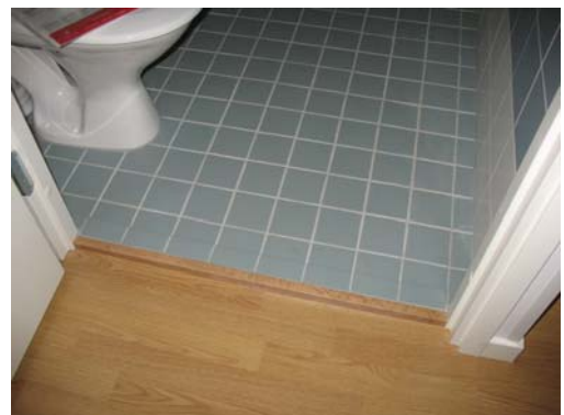
Kuva 25. Kylpyhuoneen rakokynnys.
