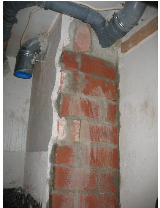
Kuva 19. Lvi-hormin muuraus
