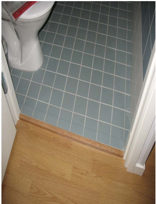
Kuva 4. Kylpyhuoneen rakokynnys
