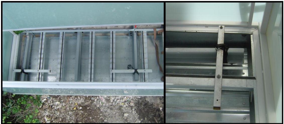
Kuva 4. Parvekkeen väliaikainen kiinnitys asennusvaiheessa
