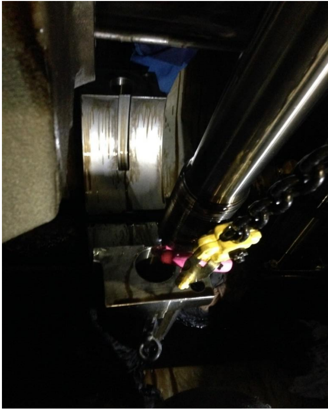
Kuva 19. Alapuoliskon lasku öljypohjaan.
