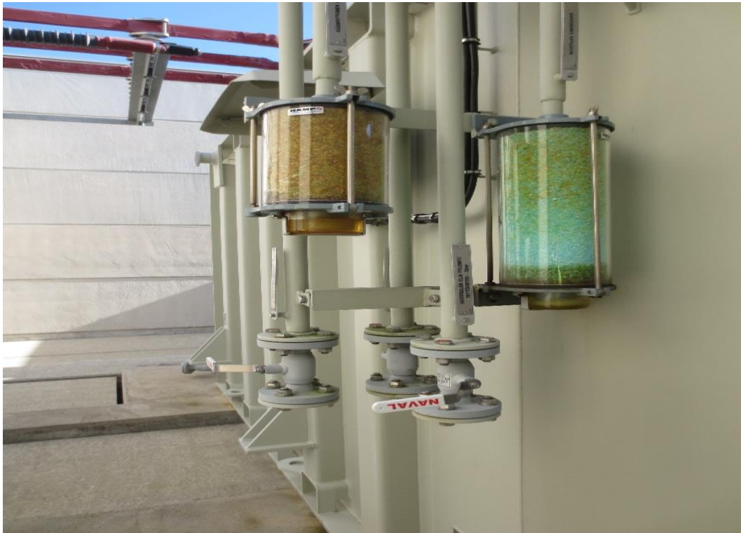
Kuva 13. Päämuuntajan ja käämikytkimien ilmankuivaimet
