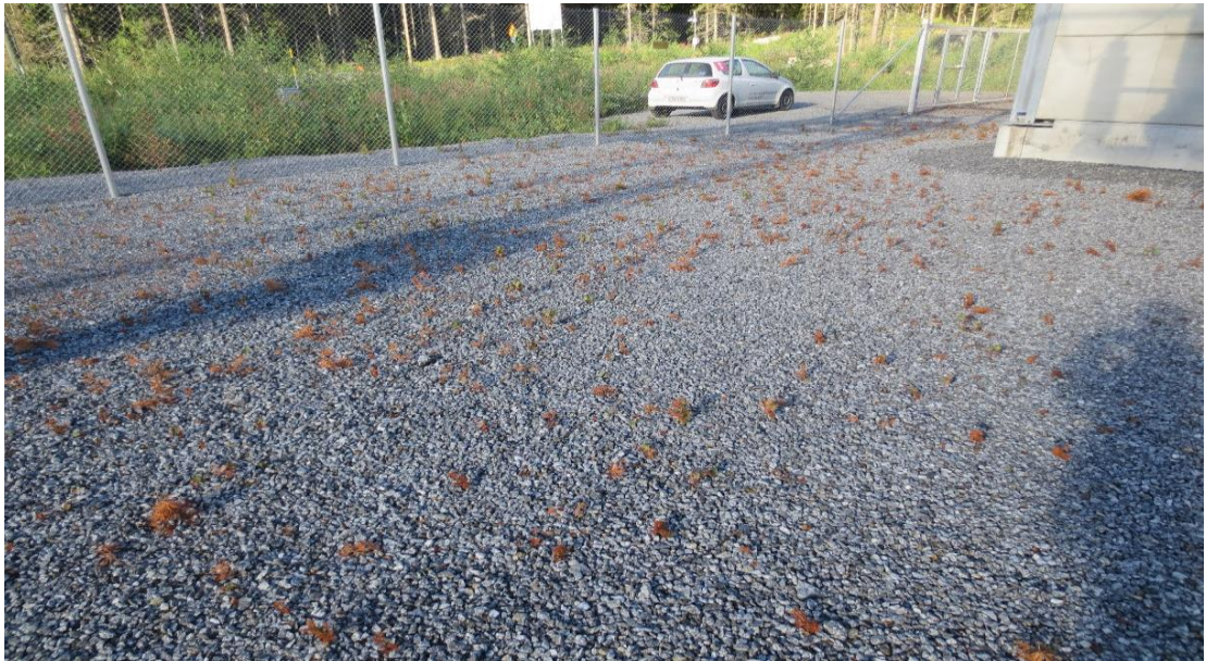
Kuva 10. Sundomin aseman pohjan myrkytetty kasvillisuus
