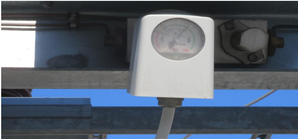
Kuva 12. Katkaisijan SF6-kaasun paineen mittari.
