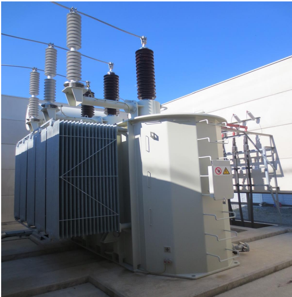
Kuva 3. Sundomin sähköaseman päämuuntaja
