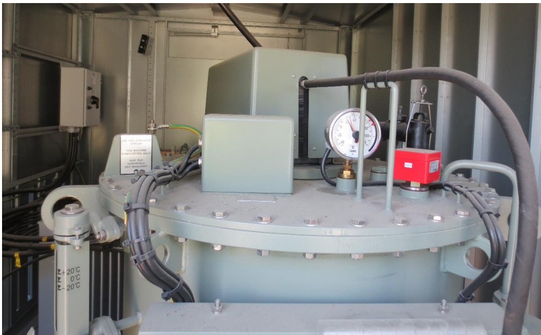
Kuva 7. Sundomin sähköaseman sammutuskuristin
