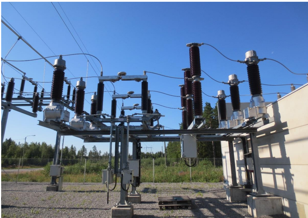
Kuva 11. Ulkokytinkentän katkaisijat ja erottimet.
