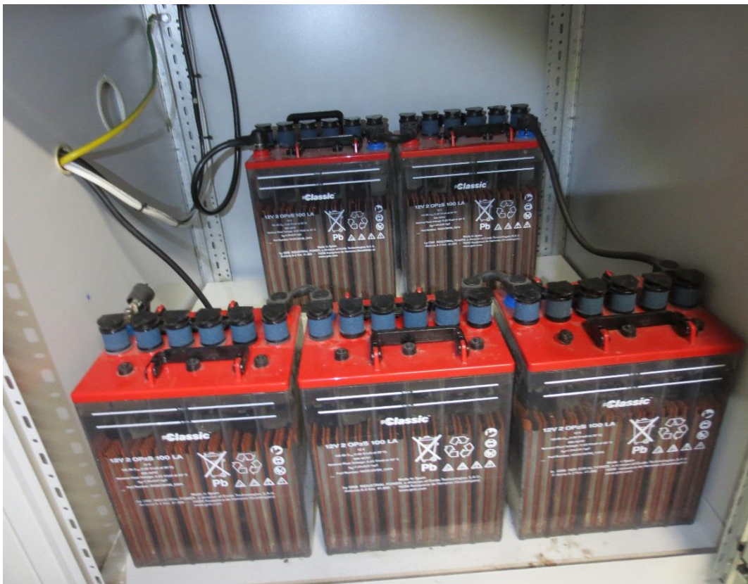
Kuva 9. Sundomin aseman akustoa
