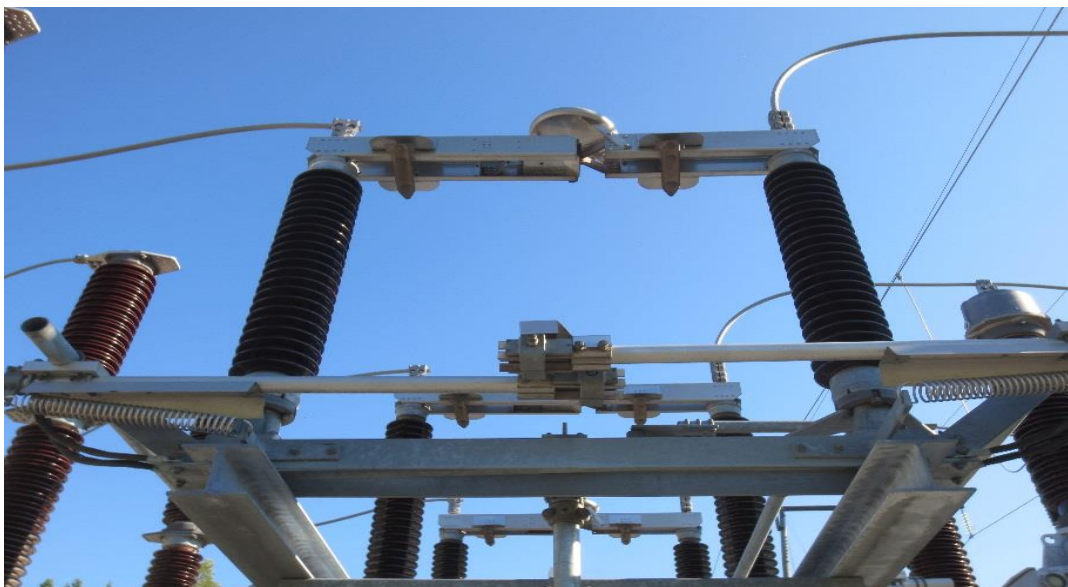
Kuva 5. Kiertoerotin Sundomin sähköasemalta
