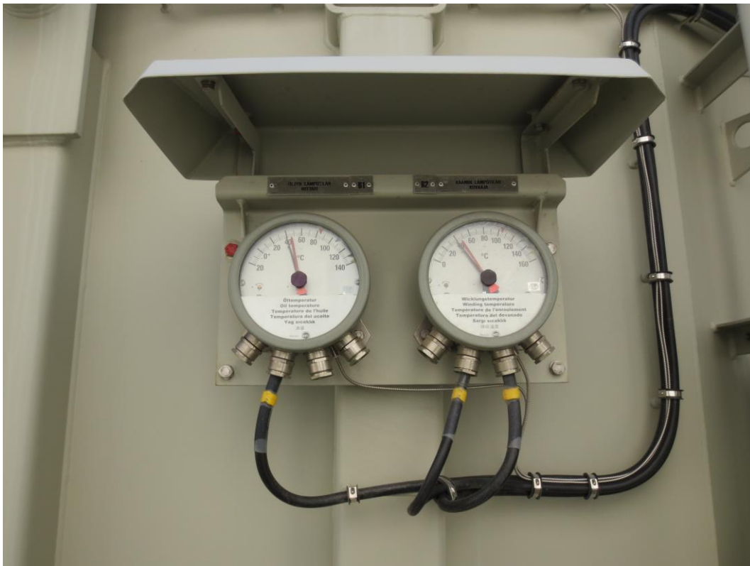
Kuva 14. Sundomin päämuuntajan käämin sekä öljyn lämpötilamittarit
