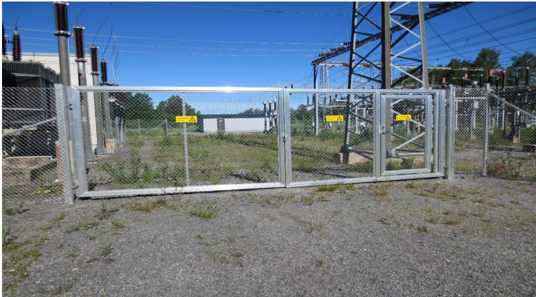
Kuva 2. Sähköasemaa ympäröivä aita ja portit sekä ”hengenvaara”-kilvet
