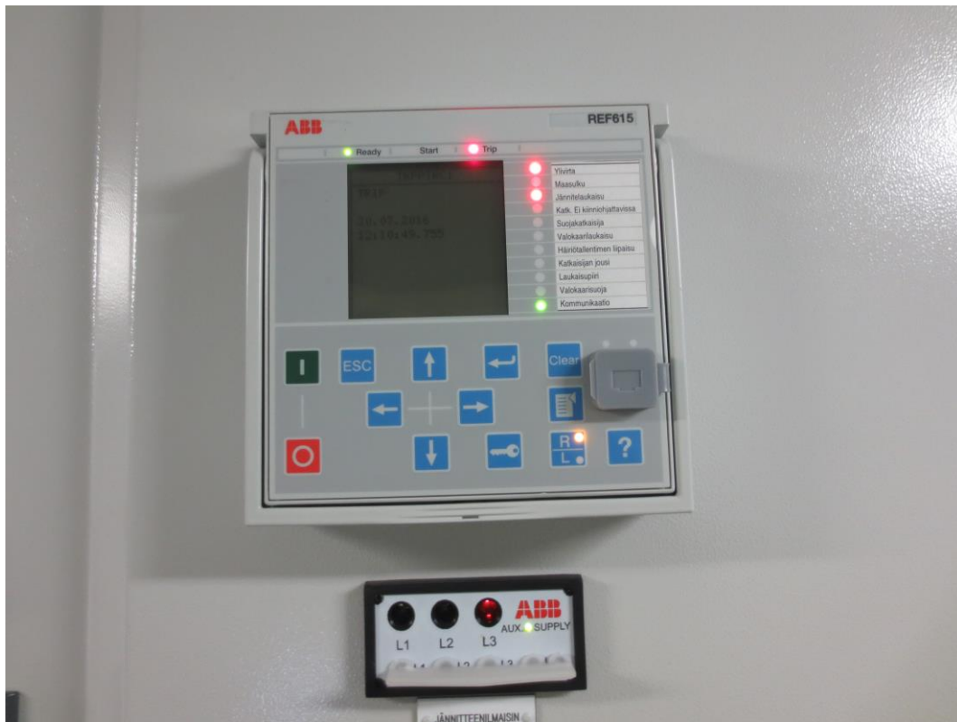
Kuva 15. Sundomin aseman ABB REF615-releen käyttöpaneeli
