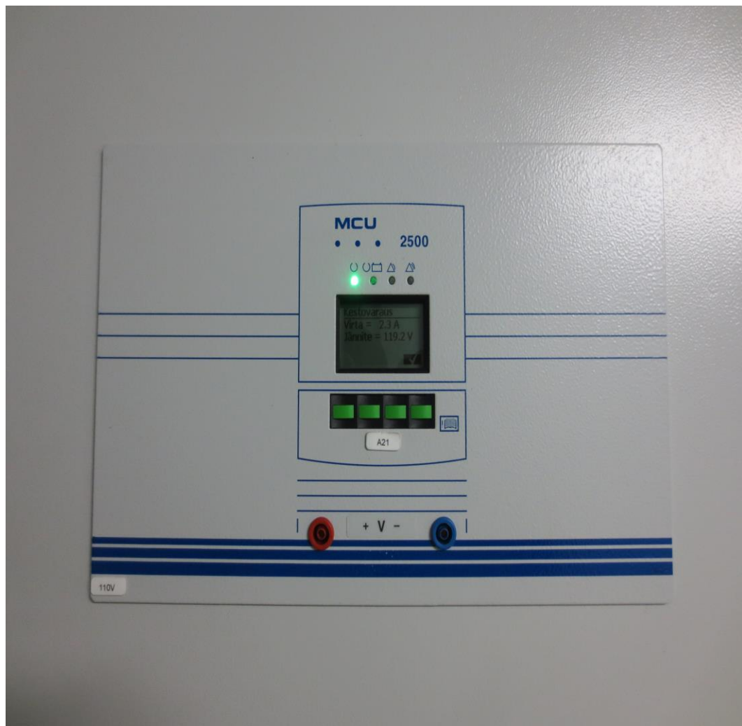
Kuva 19. Akuston lataajan mittarin näyttö.
