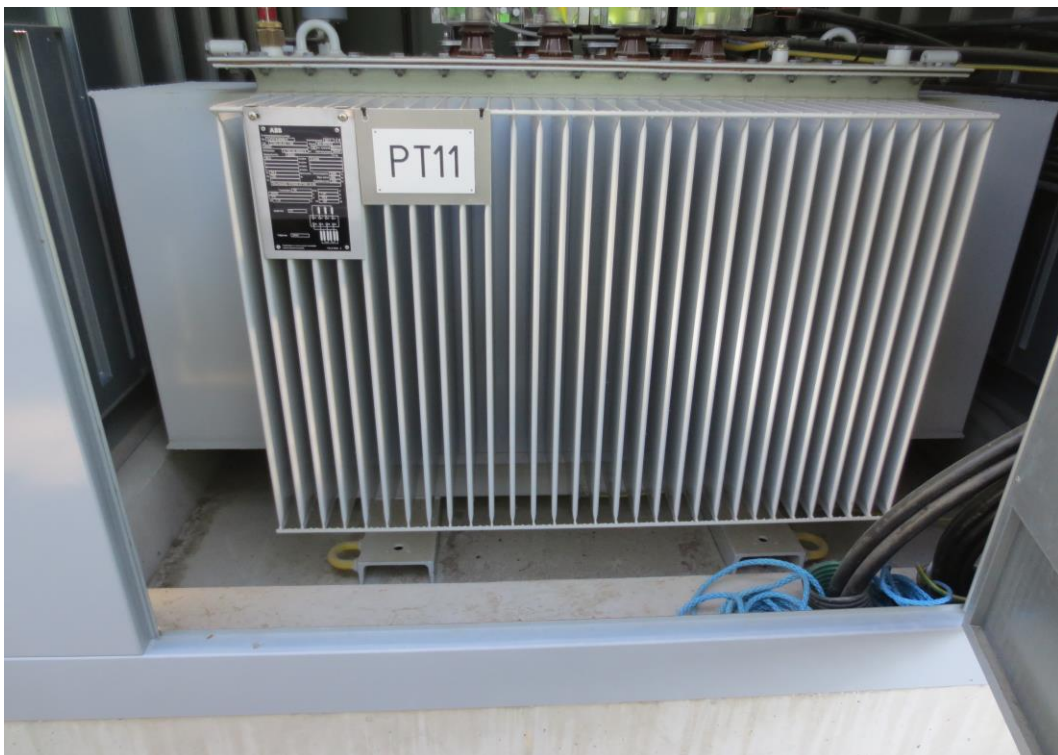
Kuva 8. Sundomin sähköaseman maadoitusmuuntaja
