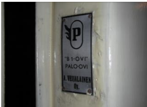
Kuva 6. B1-luokan palo-ovissa ja karmeissa käytetty merkitsemiskilpi. (Rakennustieto Oy 2016)
