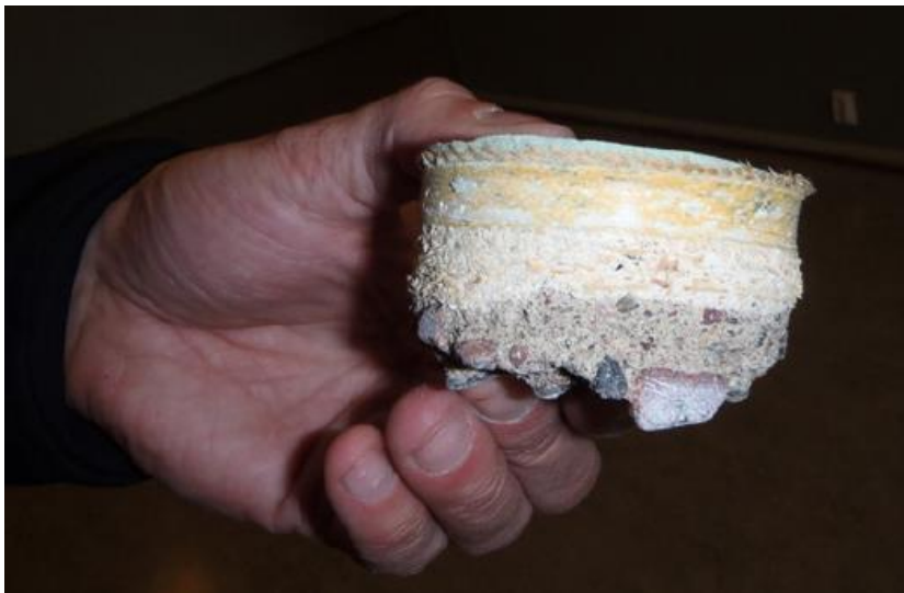
Kuva 25. Poralieriönäyte. PVC-muovimaton alla kaksi asbestipitoista magnesiummassakerrosta. Ylempi kerros on 1970-luvulta ja alempi kerros 1950-luvulta. (Rakennustieto oy 2016)
