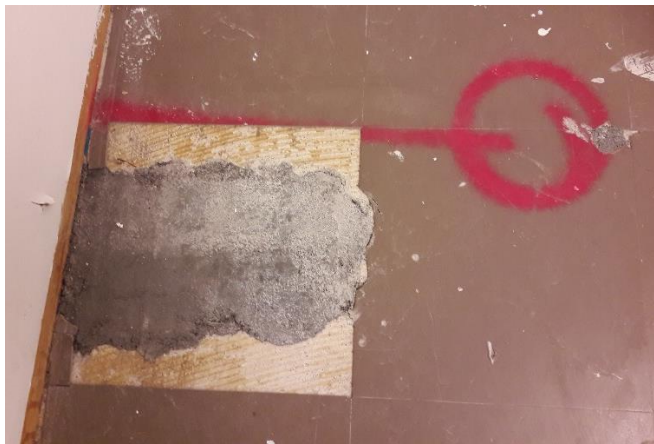
Kuvat 28 ja 29. Vinyyliasbestilaattoja kerrostalon rappukäytävässä ja virastotalossa. (Kuvat: Sini Vesterinen 2017)
