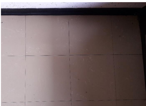
Kuvat 28 ja 29. Vinyyliasbestilaattoja kerrostalon rappukäytävässä ja virastotalossa. (Kuvat: Sini Vesterinen 2017)
