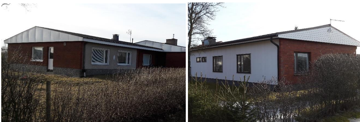
Kuvat 7 ja 8. Erilaisia asbestisementtisiä julkisivulevyjä 70-luvun taloissa. (kuva: Sini Vesterinen 2017)
