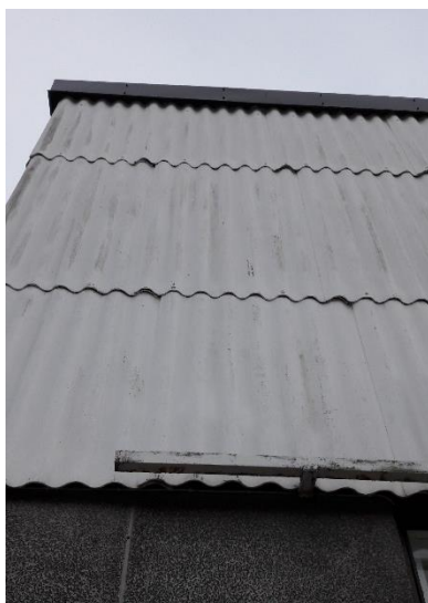
Kuvat 13 ja 14. Aaltomainen asbestisementtilevytyys julkisivussa. (Kuva: Sini Vesterinen 2017)
