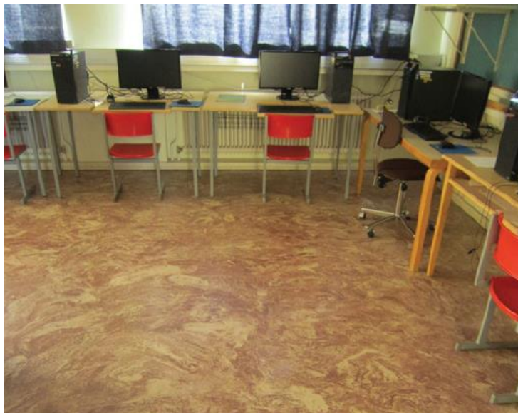
Kuva 26. Asbestipitoinen marmorikuvioinen magnesiaamassalattia. (Rakennustieto Oy 2016)
