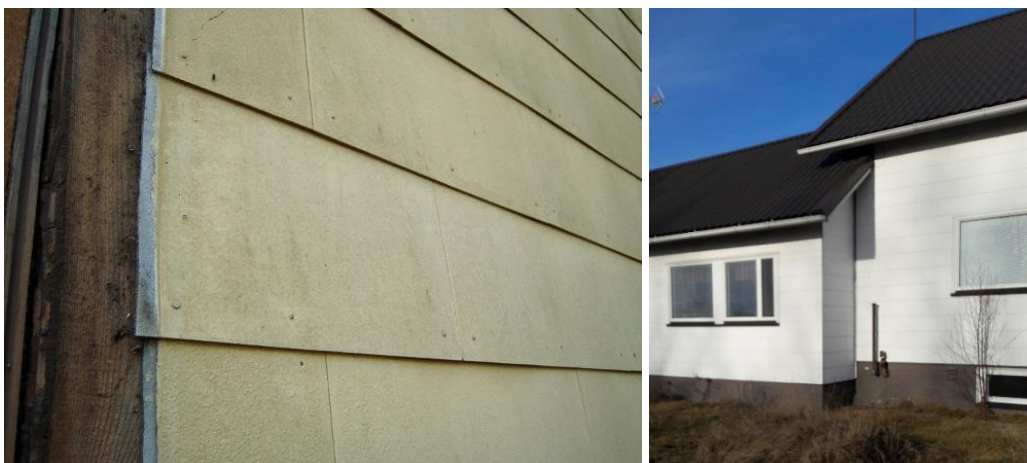
Kuva 16. Julkisivun maalattua Minerit-levytystä (Talotarinat 2015).
