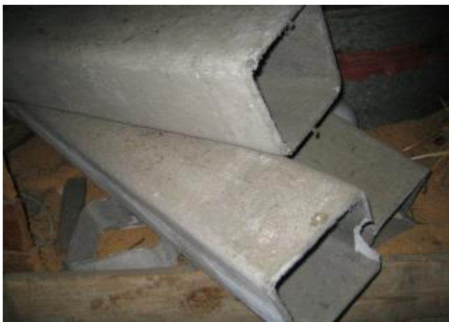
Kuva 35. Asbestipitoisia ilmanvaihtoputkia. (Rakennustieto Oy 2016)
