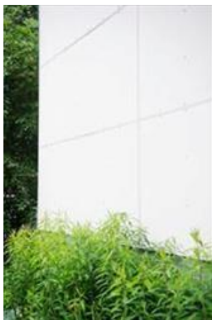
Kuva 11. Julkisivun Minerit-levytystä. (Kuva: Pekka Hänninen. Ympäristöhallinto 2017)
