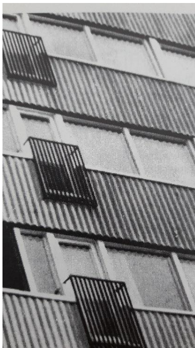
Kuva 9. Aaltolevyverhous. (Rakennustieto Oy 1993)
