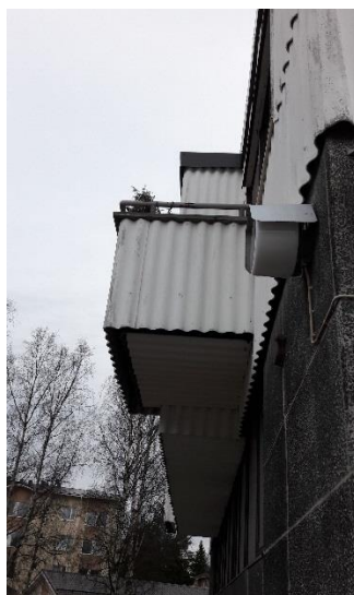
Kuvat 13 ja 14. Aaltomainen asbestisementtilevytyys julkisivussa. (Kuva: Sini Vesterinen 2017)
