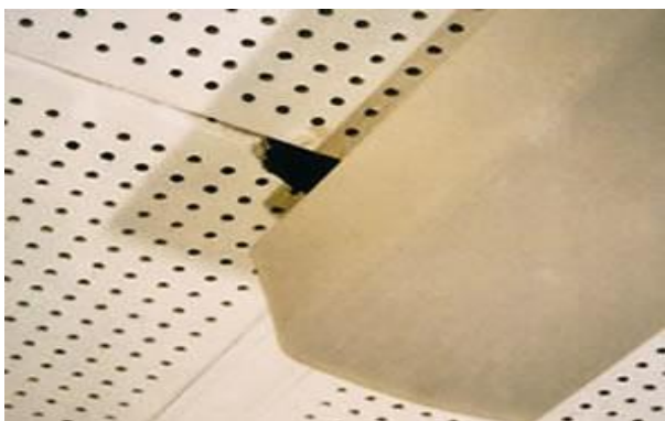
Kuva 4. Rei'itetty sisäkaton verhouslevy. (Health and safety executive 2017)
