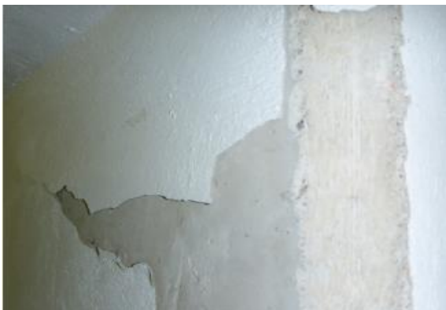
Kuva 34. Asbestia käytettiin maaleissa ja tasoitteissa. (Rakennustieto Oy 2016)
