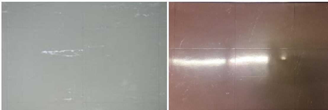
Kuva 30. Finnflex vinyylasbestilaattaa. (Kuva: Pekka Hänninen. Ympäristöhallinto 2017)
