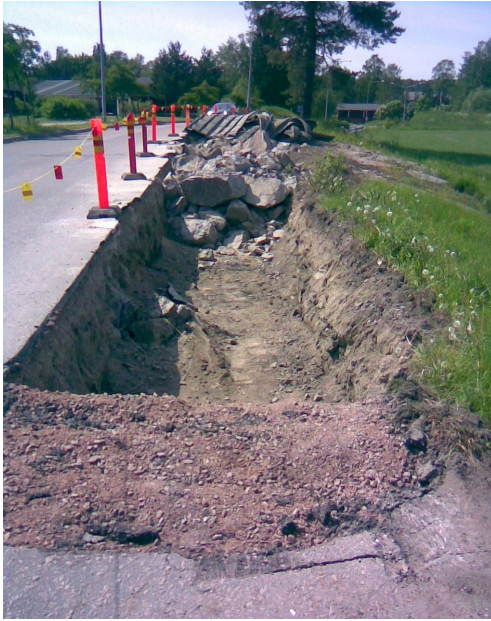
Kuva 6. Louhittu kanaali (Kuva: Kimmo Mäkelä)
