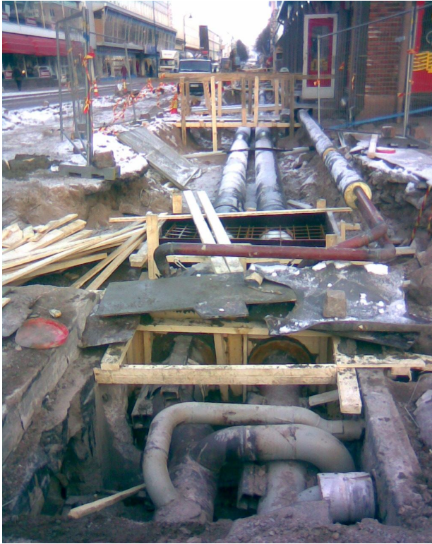
Kuva 10. Kaukolämpötyömaa vilkkaalla kauppapaikalla. (Kuva: Kimmo Mäkelä)
