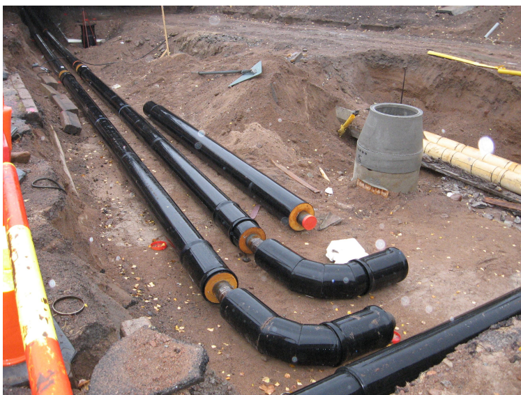
Kuva 9. Vanha betonikanavajohto korvataan 2Mpuk-johdolla.
