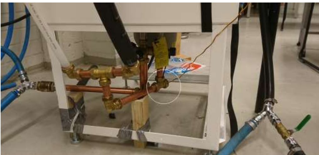
KUVA 3. Varaajan kytkentä kun LVK-pumppu oli kytkettynä (ympyrällä merkitty mittauspiste 1)
