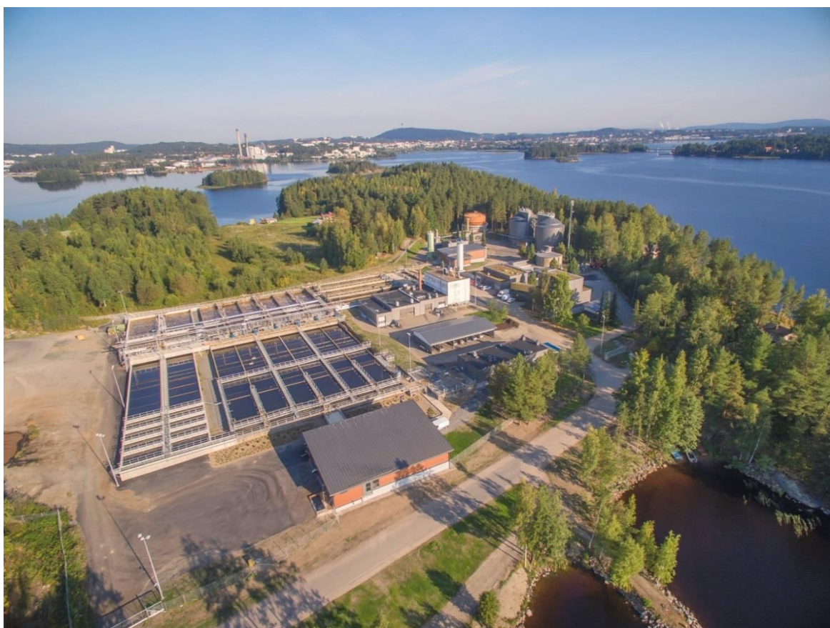
Kuva 2. Ilmakuva Lehtoniemen jätevedenpuhdistamosta saneerauksen jälkeen (Hiltunen, 2017-02-09)
