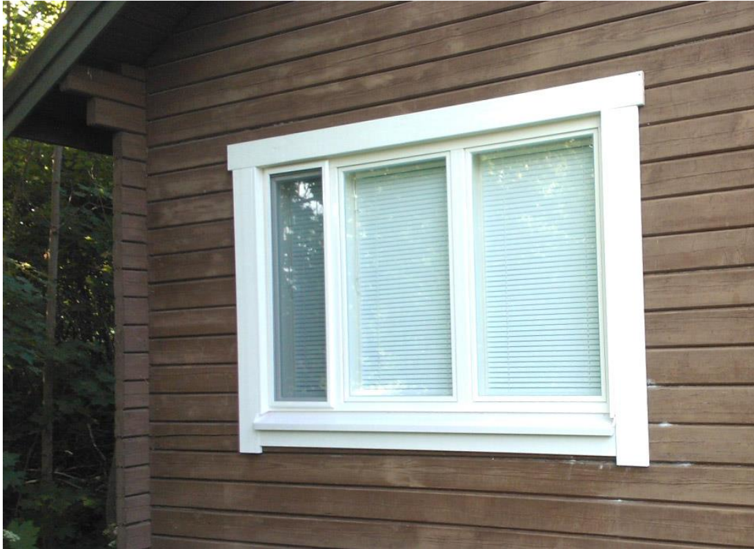
Kuva 13. Kuvassa saneerauskohteeseen vaihdettu puu-alumiini ikkuna (Lämpölux, 2017)
