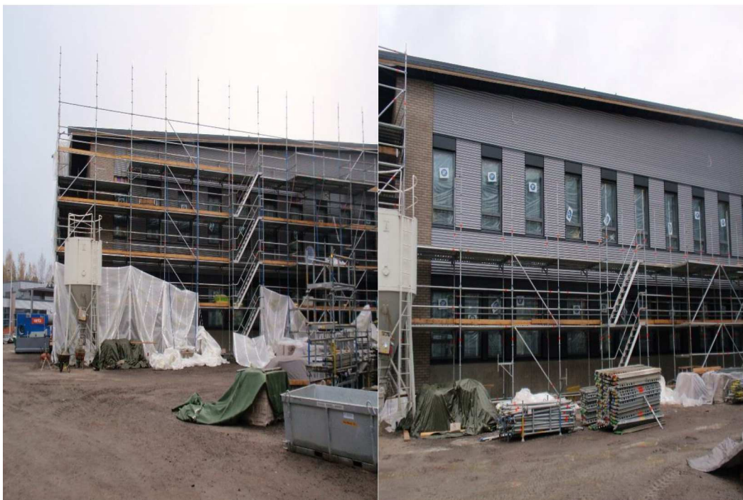
Kuva 7. Sääsuojan alta paljastuu valmis ulkovaippa.
