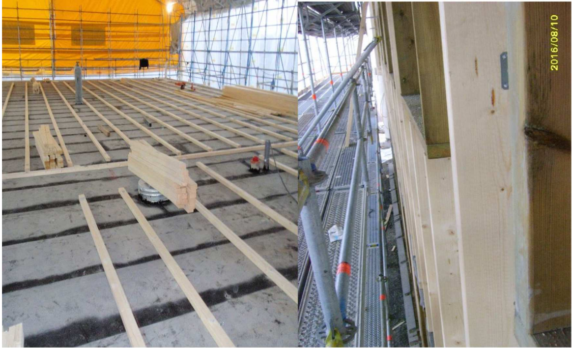
Kuva 3. Yläpohjan ja ulkoseinän puutöitä sääsuojassa.
