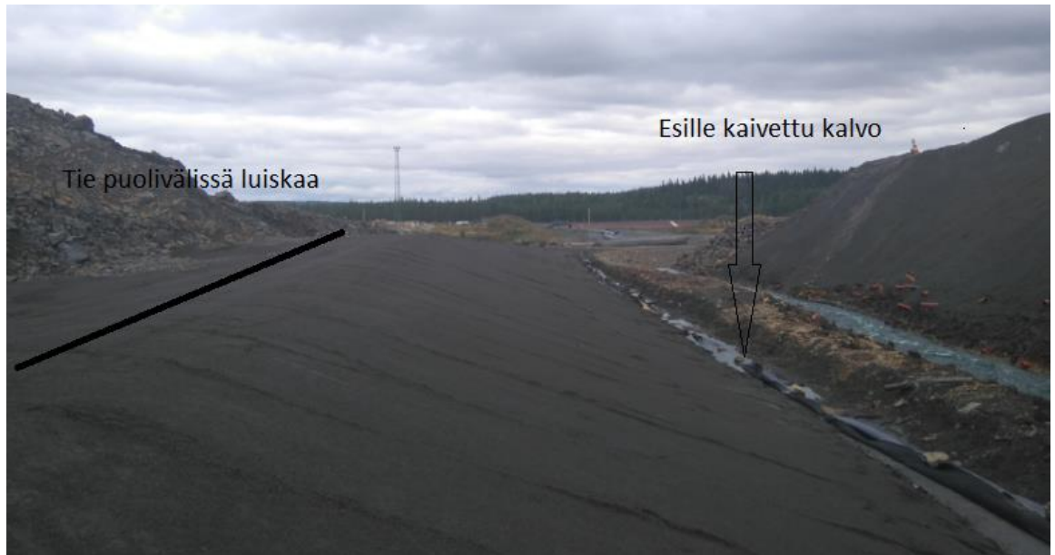
Kuva 20. Lohko 2:n ja 3:n välinen luiska ja alapuolinen suojakerros jyrättynä.
