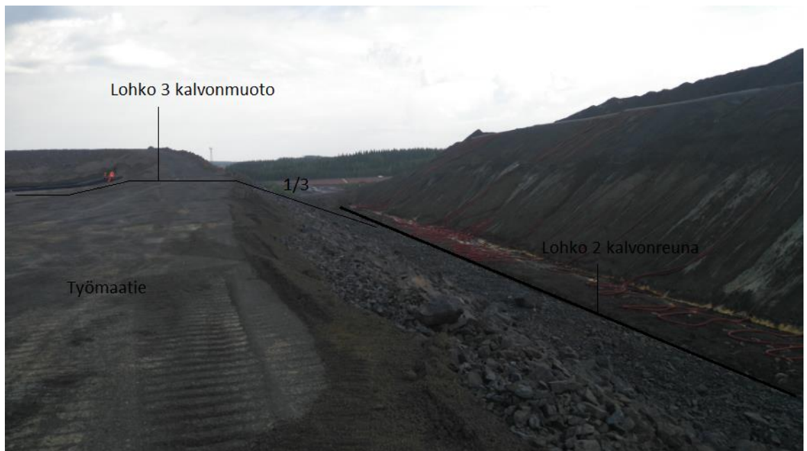
Kuva 19. Lohkojen 2 ja 3 välinen luiska ja kalvon liitoskohta.
