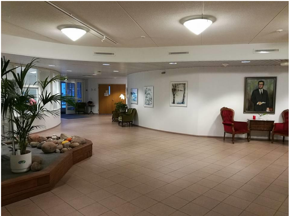
Kuva 4. Kuva aulasta. Katossa etualalla kartion malliset lamput, kiskot spottivaloille, takana upotettavat kattovalot ja kappelin oven edessä lattiavalaisin. (© Henriksson 2016)
