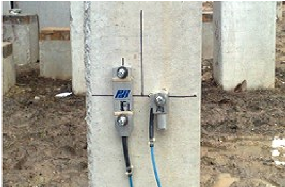
Kuva 5. Kuvassa paaluun kiinnitettävät PDA-anturit (Soil Investigation Pte LTD n.d.).
