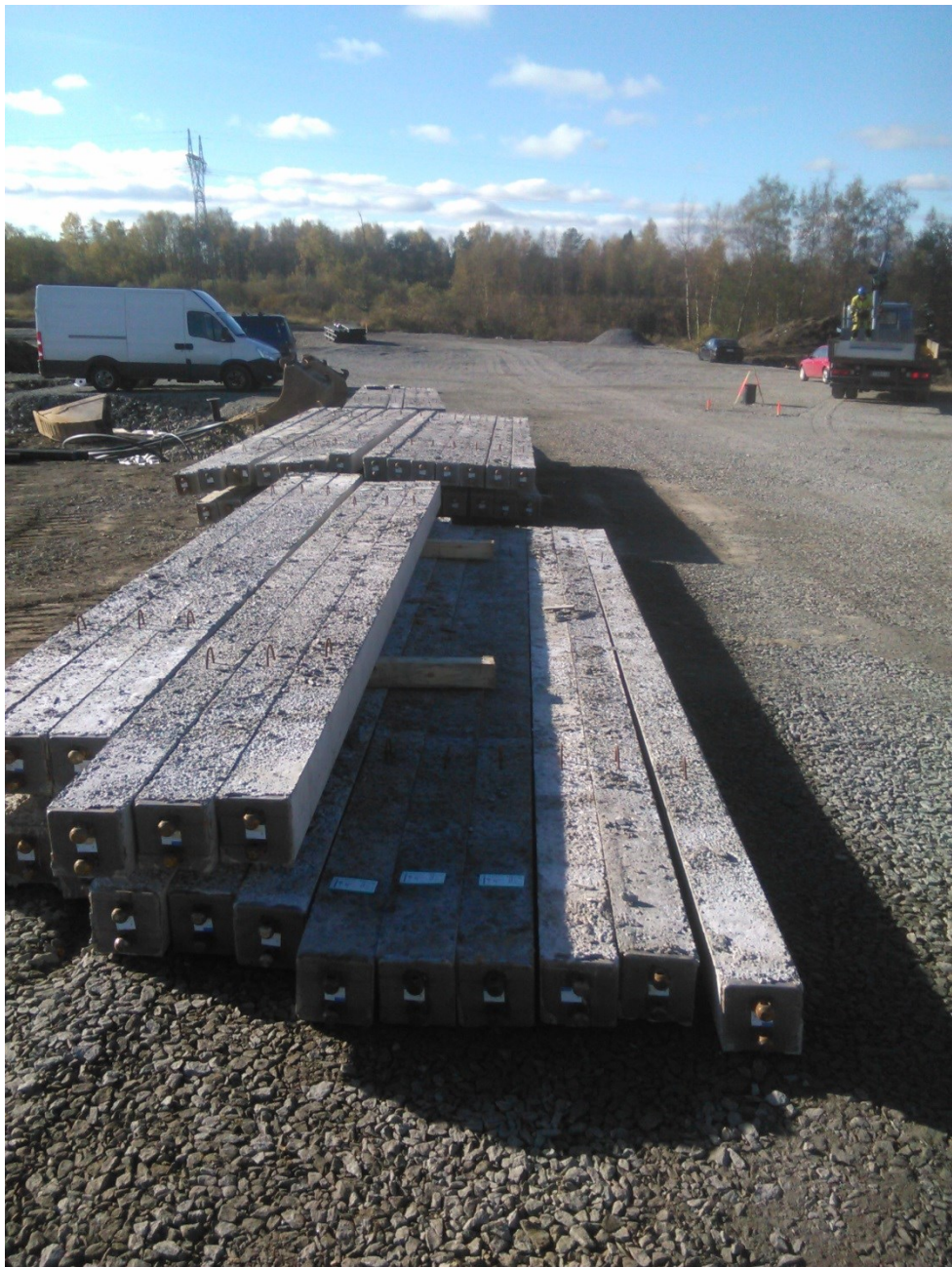
Kuva 2. Kuuden metrin pituinen Luja-pienpaalu (180*180 mm) odottamassa paalutusta työmaalla. (Kuva: Sami Patjas)
