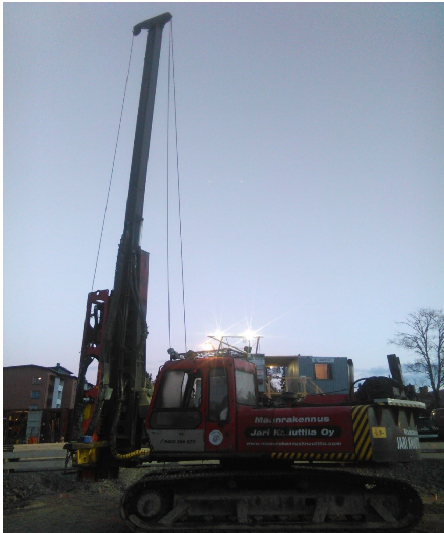
Kuva 1. Paalutuskone, jossa on käytössä yksitoiminen hydraulijärkäle. (Kuva: Sami Patjas)
