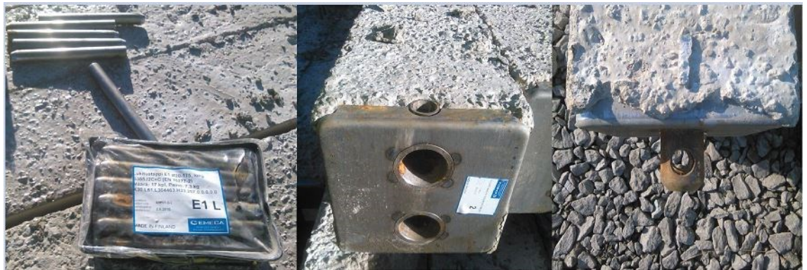
Kuva 3. Kuvassa Luja-pienpaalun jatkososat: vasemmalla jatkostappi, keskellä naarpää ja oikealla urospää. (Kuvat: Sami Patjas)
