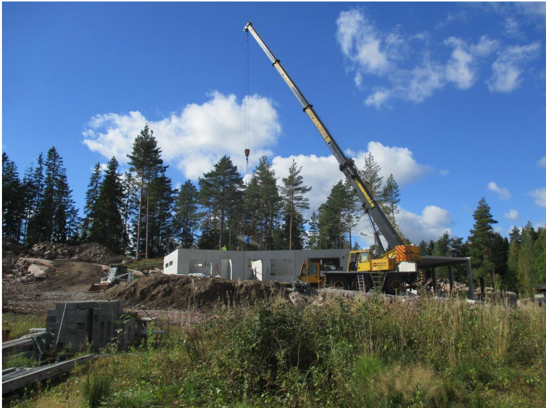
Kuva 1. Lokomo 393 onteloasennuksessa rakennustyömaalla.
