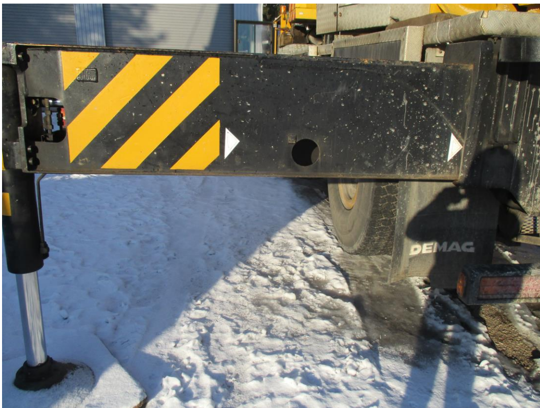
Kuva 8. Tukijalat käytiin läpi repeämien ja sylinterien vuotojen varalta.
