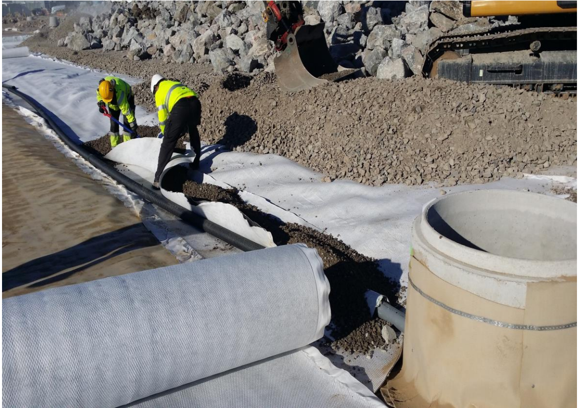
KUVA 3. Salaojapainanteiden rakentaminen (Currie, 2016).
