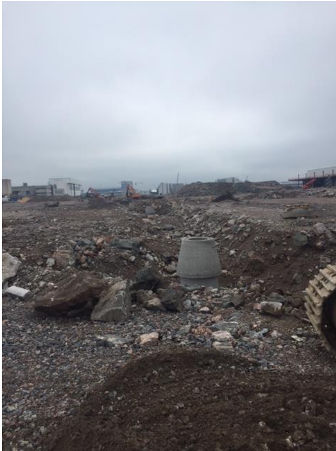
KUVA 9. Lopputäyttöjen teko Helsinki-Vantaa lentoasemalla 2016.
