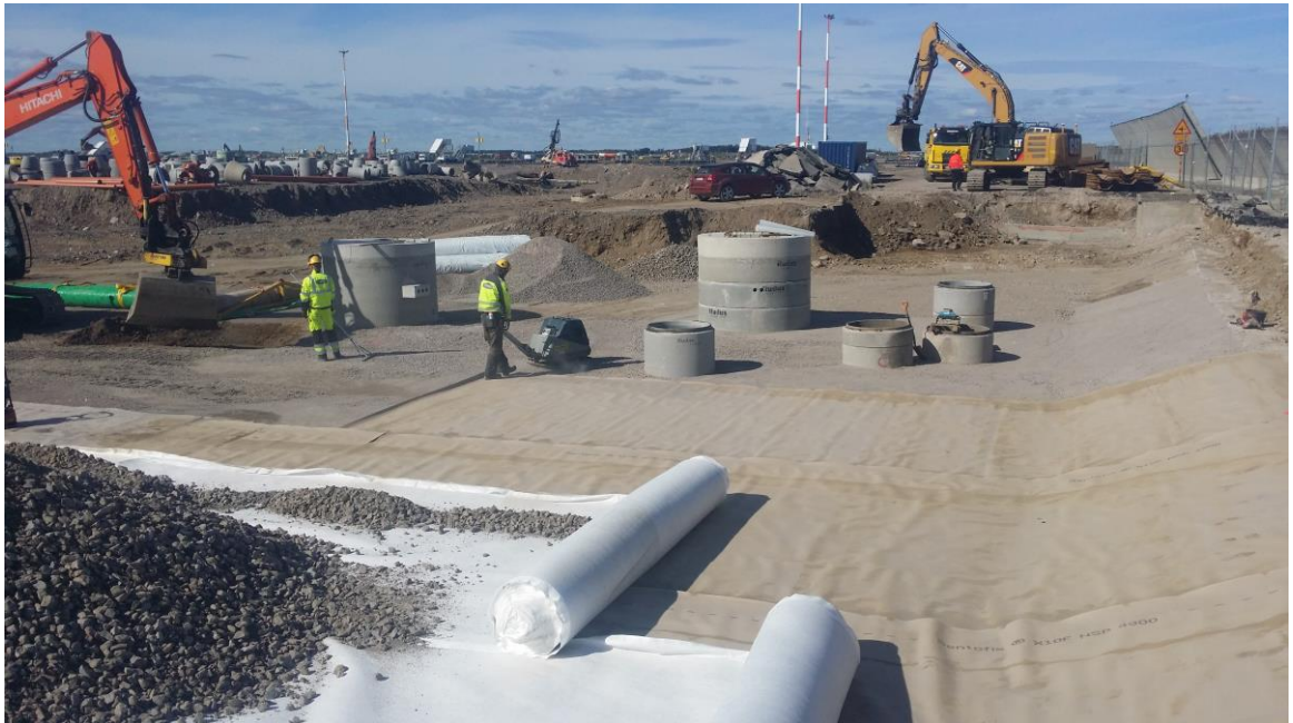
KUVA 2. Työvaihekuva bentoniittimaton ja HDPE-kalvon asennuksesta (Currie, 2016).
