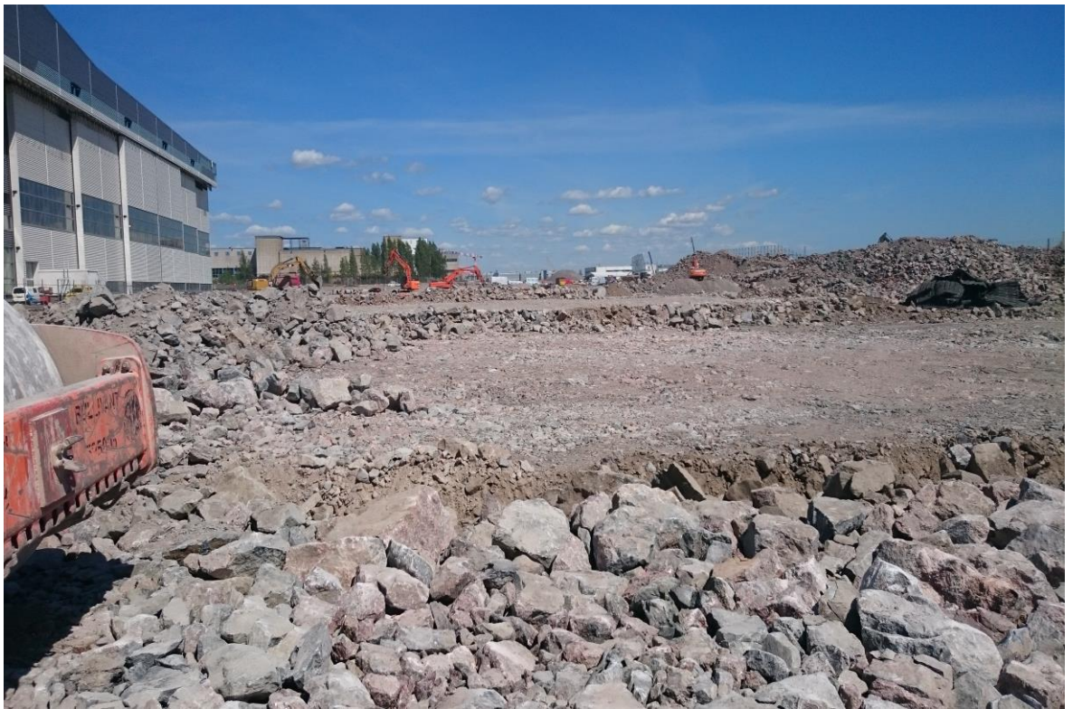
KUVA 4. Rakenteiden tekoa LEKO 7:n edustalla.
