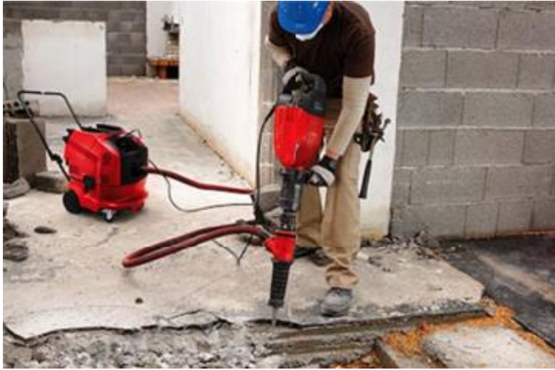
KUVA 3. Kohdepoistoimuri piikkausvasarassa.
