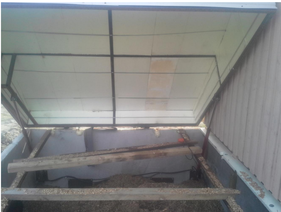
Figur 4. Taket över flisfickan gjordes av metall.
