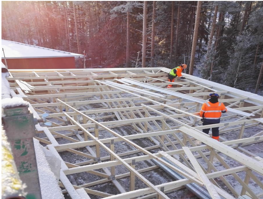
Kuva 9. Paikalla rakennettavan vesikaton rakentamista.
