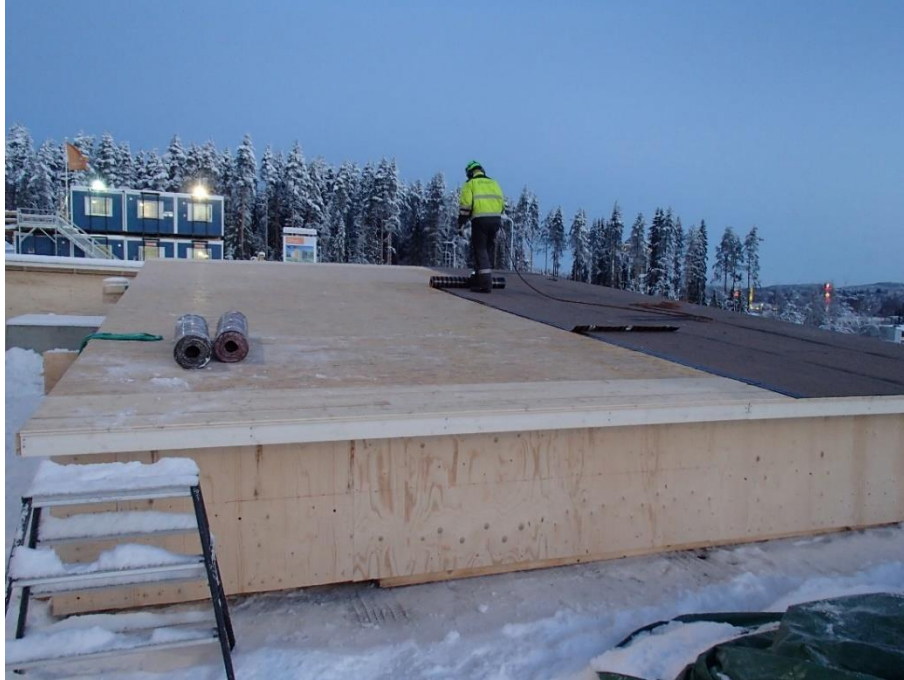
Kuva 7. Aluskatteen asentaja asentaa kermiä moduuliin.
