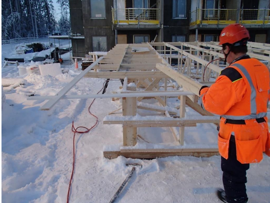
Kuva 8. Työskentelyä räystäillä maan pinnalla.
