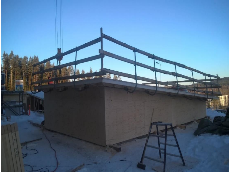
Kuva 6. Vesikattomoduli valmiina katolle nostoa varten.
