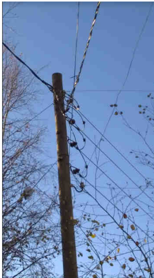
Kuva 17. Esimerkki saneeraukseen tulevasta vanhasta PJ-avojohtoverkosta, jossa alimpana kulkee asiakkaan kiinteistöverkon N-johdin.
