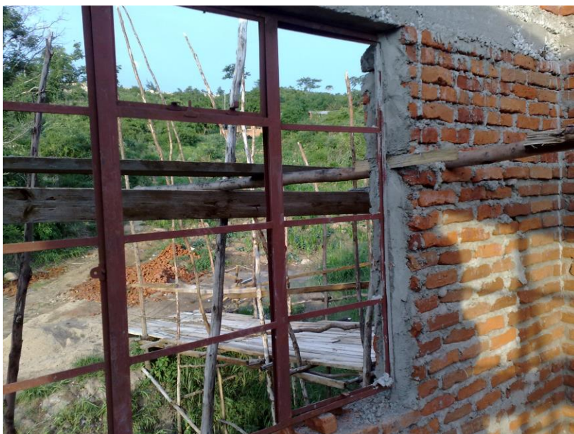
KUVA L2.8. Ikkunakehikko liitetään seinään muurauslaastilla
