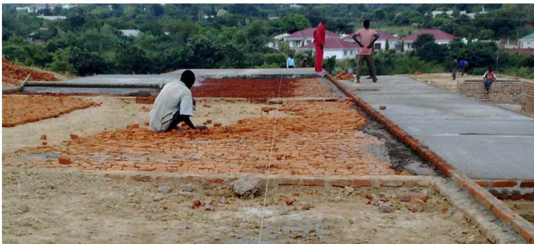
KUVA L2.5. Alapohjan tiilikerroksen ladonta ja lattiavalu meneillään
