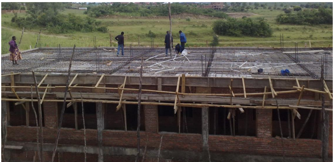
KUVA L2.12. Sähköputkia asennetaan asuntolan välipohjaan
