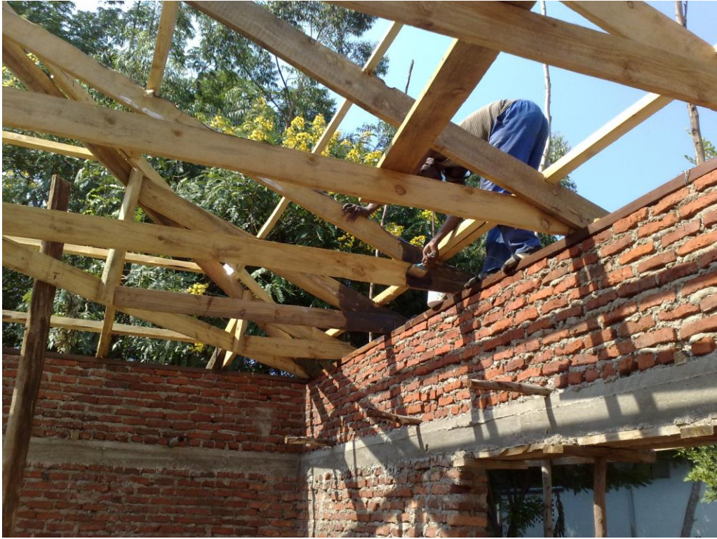
KUVA L2.9. Puunsuoja-aineen sivelyä silitystalon kattotuoleihin
