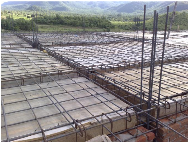
KUVA 16. Asuntolan palkkilaataston raudoitus tekeillä
