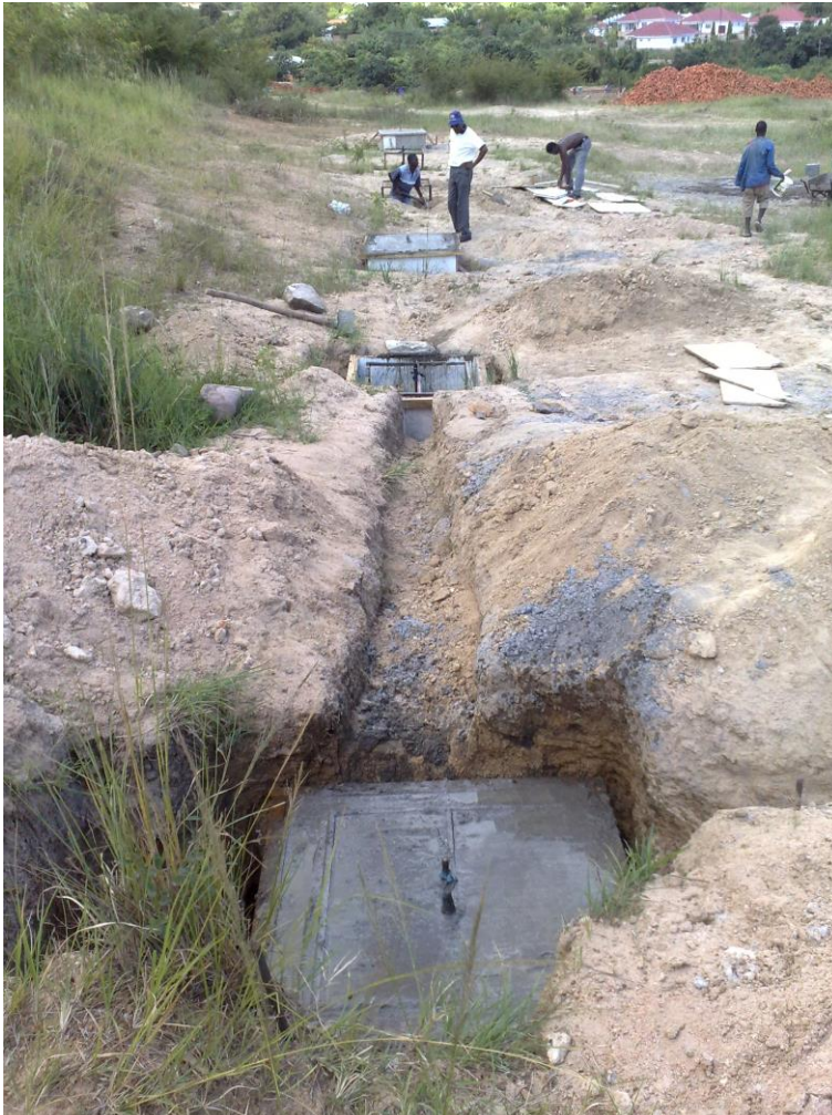
KUVA L2.2. Vastavalettuja alakoulun kokoontumishallin pilarianturoita
