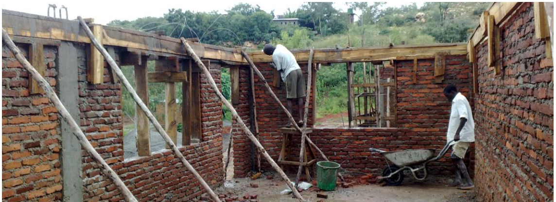
KUVA L2.7. Asuntolan ylimmän kerroksen rengaspalkkivalu
