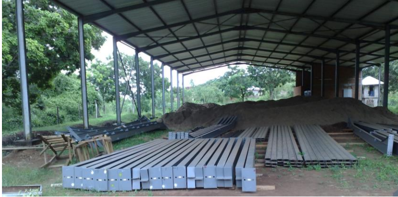
KUVA 6. Keskenkäynnissä oleva teräsrakennehalli seuraavan hallin osien varastona
