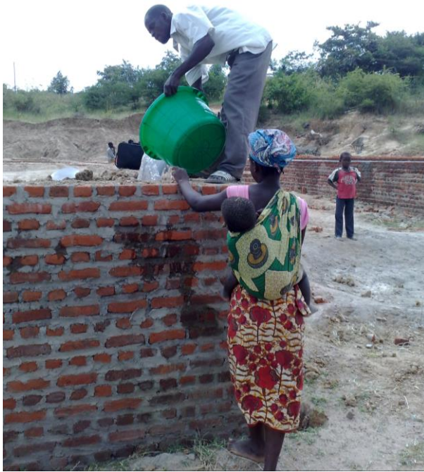
KUVA 4. Vettä lisätään alakoulun luokkarakennuksen alustäytön tiivistämiseksi
