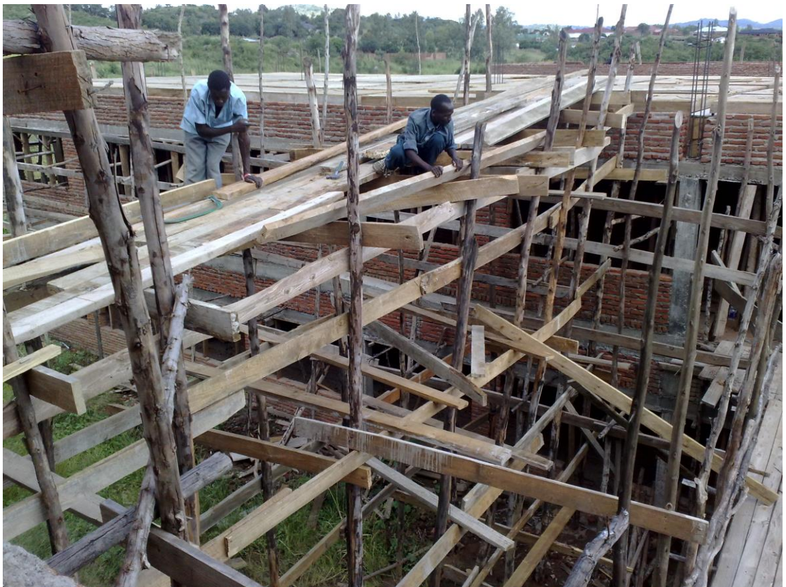
KUVA 18. Kulkusillan rakentaminen kahden kerrostalon välille holvivalua varten
