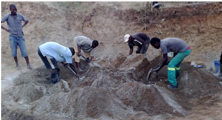
KUVA 7. Betonin sekoitusta ennen veden lisäämistä
