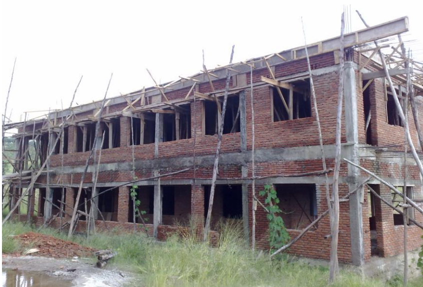
KUVA 10. Kerrostalon seinärakenne
