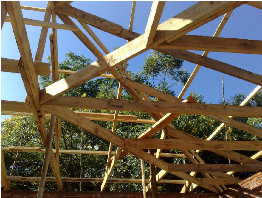
KUVA 11. Silitystalon aumakattorakenteita
