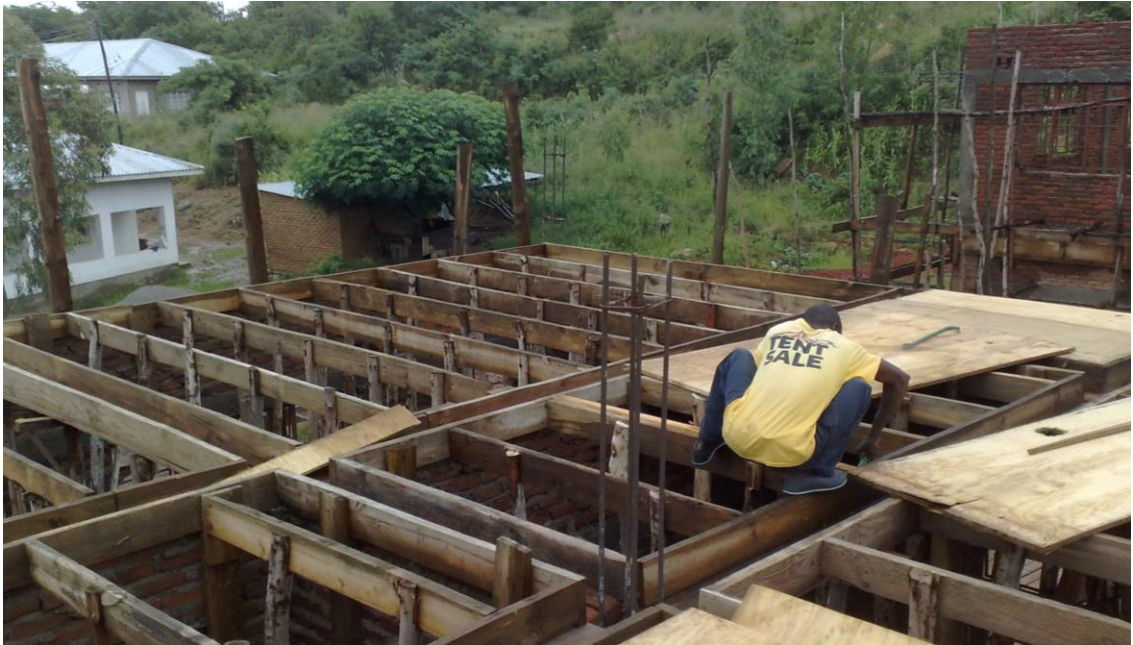
KUVA 12. Yliopiston asuntolan holvimuotti levytysvaiheessa
