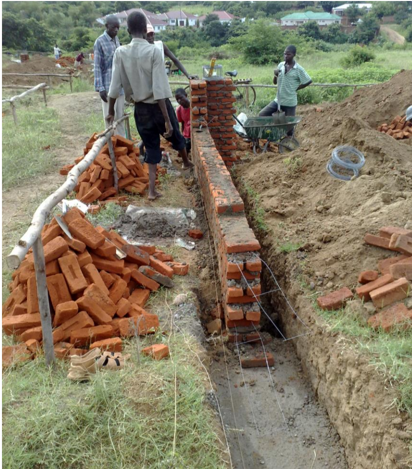
KUVA 8. Luokkarakennuksen perusmuuria muurataan porrastetun anturan päälle
