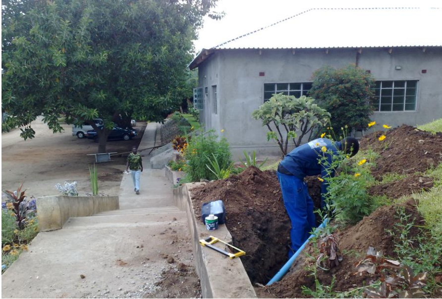
KUVA L2.1. Maakaapelia vedetään vastarapattuun yliopiston hallintorakennukseen
