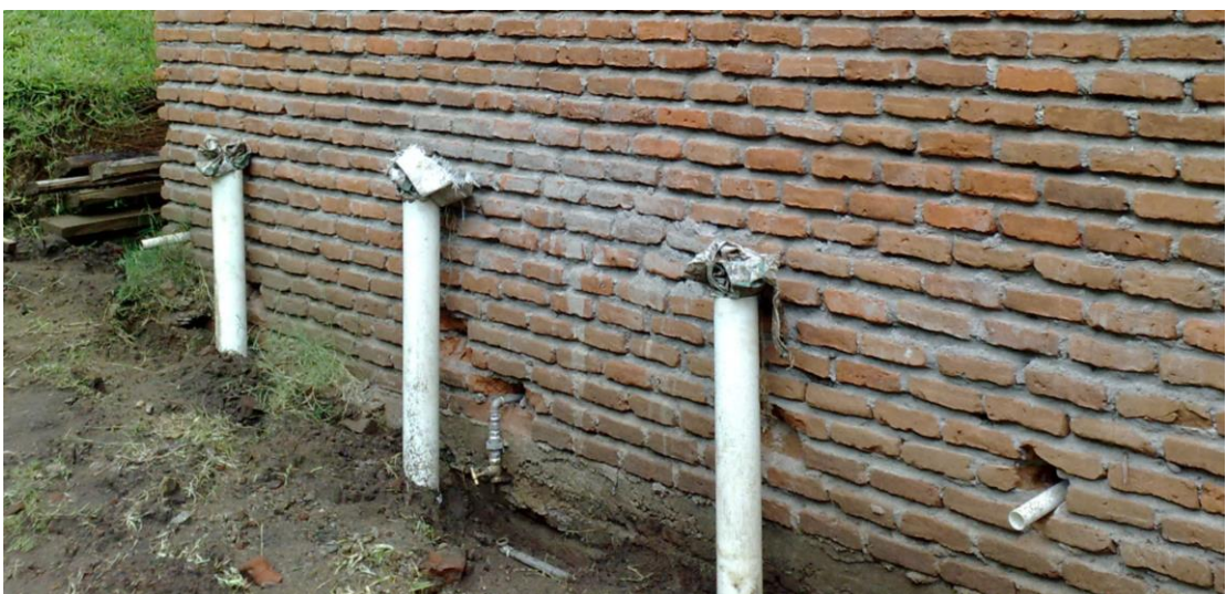
KUVA 13. Viemärinousut ennen vessojen vaakayhteisiin liittämistä
