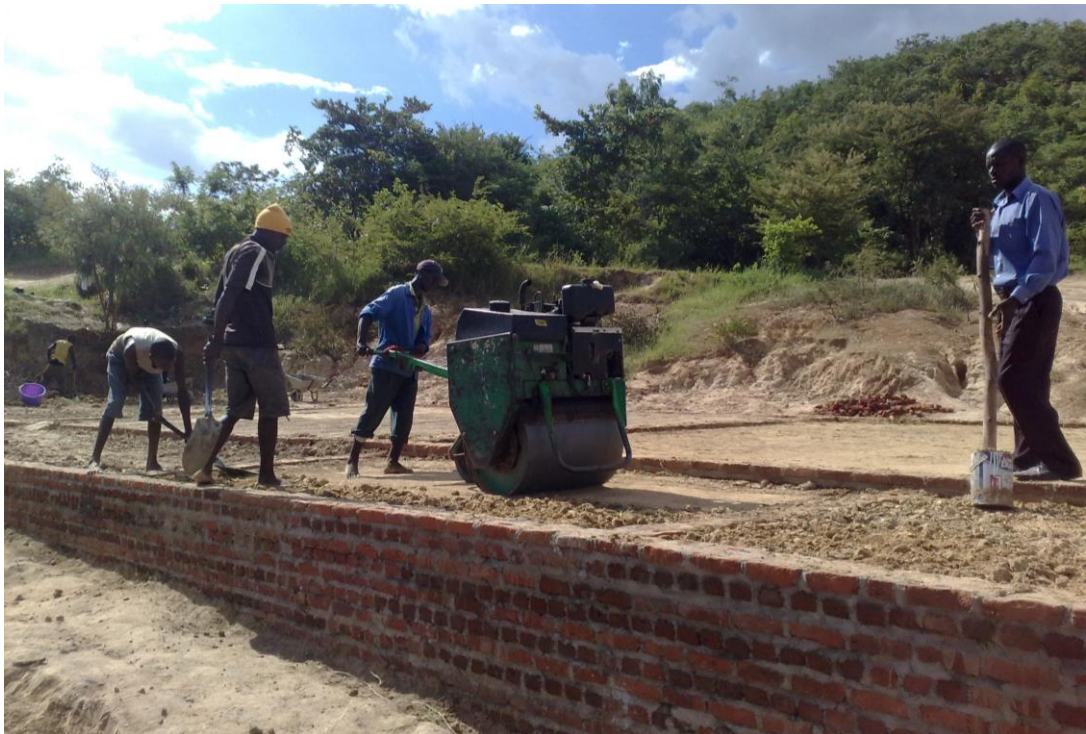
KUVA L2.4. Luokkarakennuksen alustäyttöä tiivistetään
