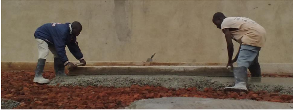
KUVA 9. Silitystalon lattiavalun korkokaistan tiivistystä
