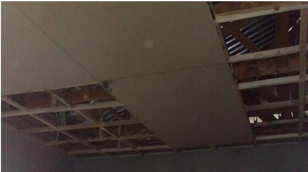
KUVA L2.10. Hallintorakennuksen sisäkattolevytystä
