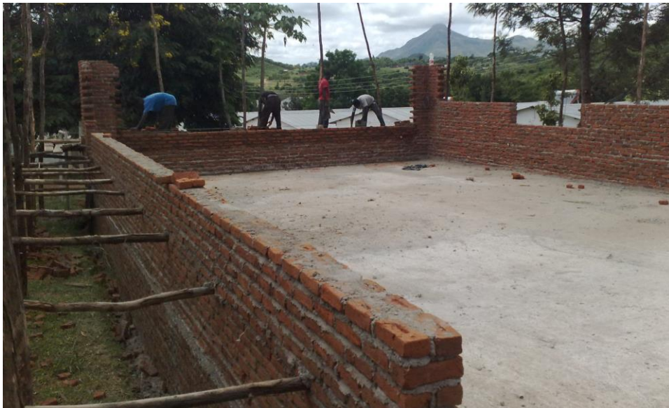
KUVA L2.6. Silitystalon seinien muurausta
