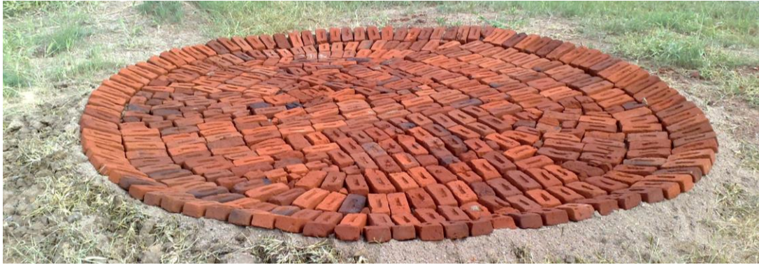
KUVA L2.3. Vielä käyttämätön alusta betonin ja laastin sekoitukseen
