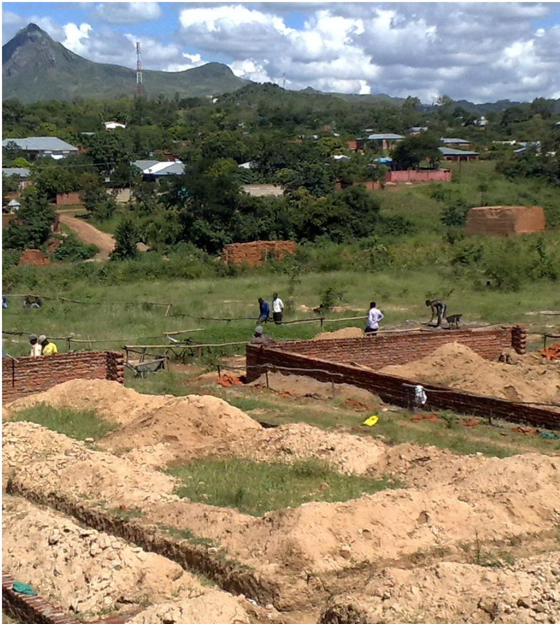
KUVA 17. Alakoulutyömaan takana näkyy muutama poltettu tiilimiilu
