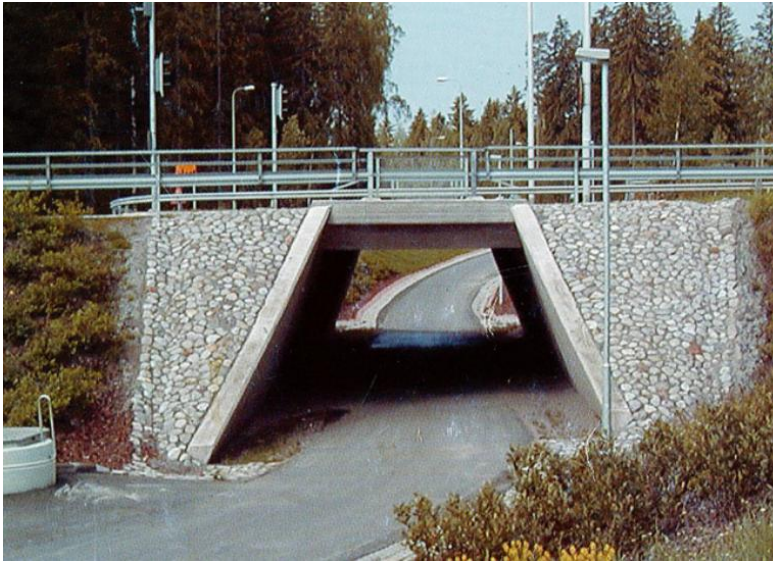
KUVA 1. Teräsbetoninen vinojalkainen laattakehäsilta Blk II (3, s.1)
