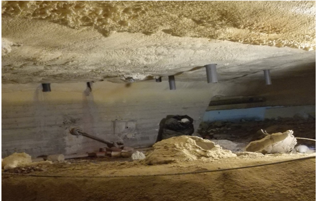
Kuva 9. Tuulettuvan alapohjan ruiskueristys valmiina. Eristyspaksuus 150mm.
