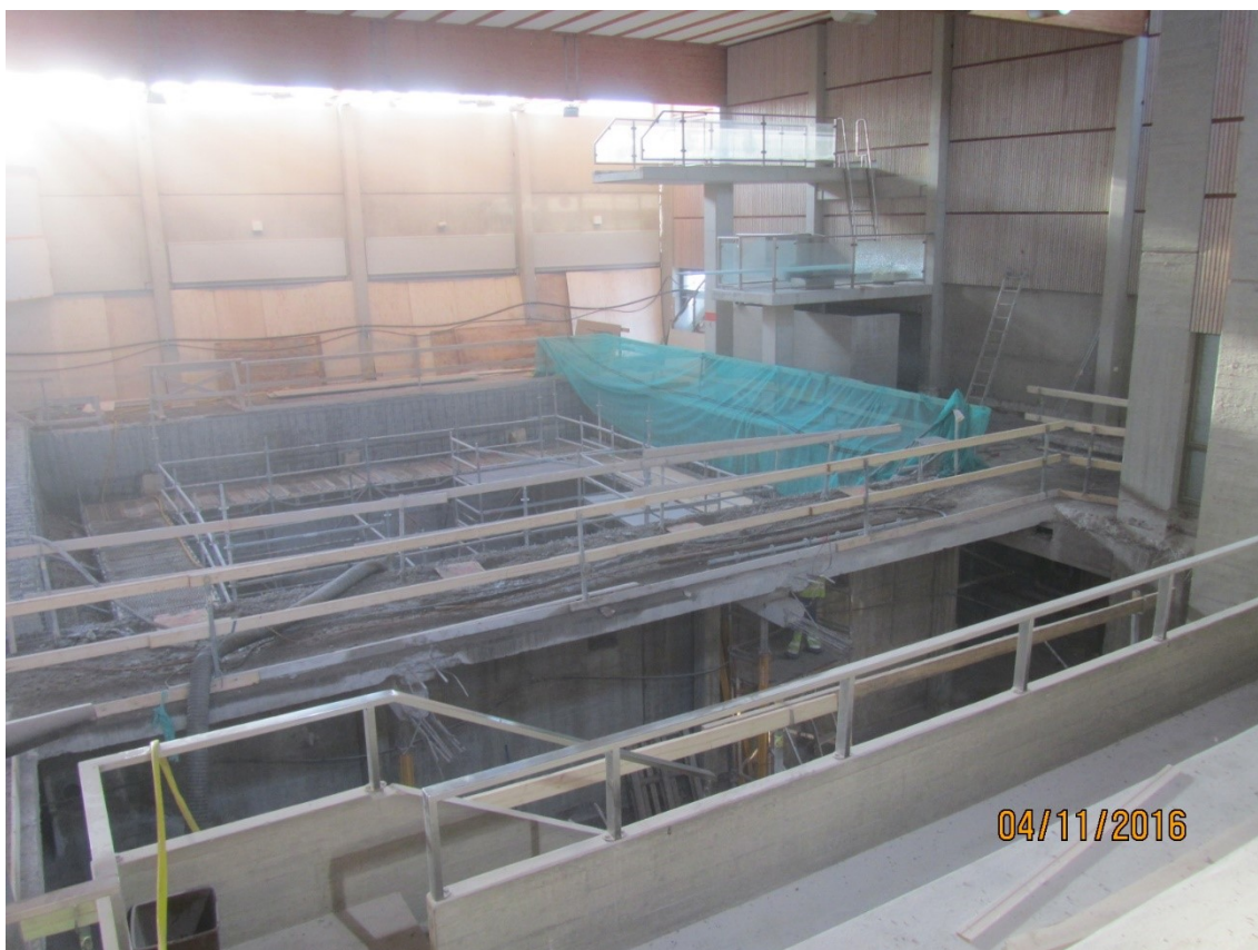
Kuva 10. Hyppyaltaan vesipiikkauksen telinerakenteet (Hämeenlinnan uimahallin projektipankki, 2016).
