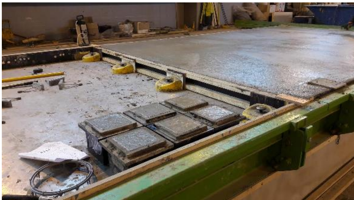
Kuva 9. Olosuhdekoekappaleet valettuina, vertailtavan väliseinäelementin vieressä.
