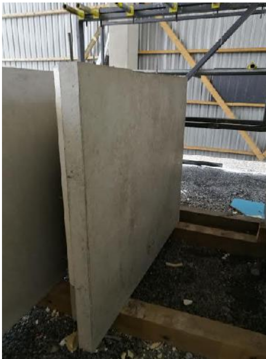
Kuva 1. Toimitusvalmis betonirakenne, sokkeli-elementti.
