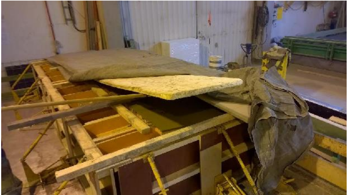
Kuva 4. Eristesokkelielementti valettuna ja peitettynä.
