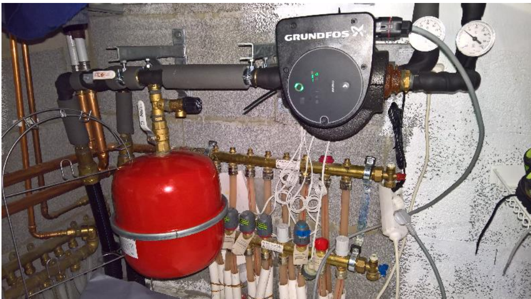
KUVA 4. MAGNA1 25-80 asennettuna, varoventtiilin ulospuhallusputki vielä asentamatta
