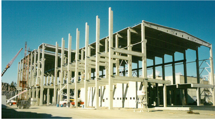
Kuva 9 Paperitehtaan pystytysvaihe (Hollo 1995)
