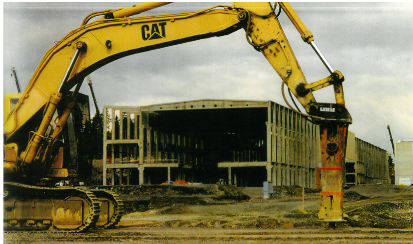
Kuva 13 Erään paperitehtaan elementtirakenteinen runko 90-luvulla (Jouni Hollo 2001)
