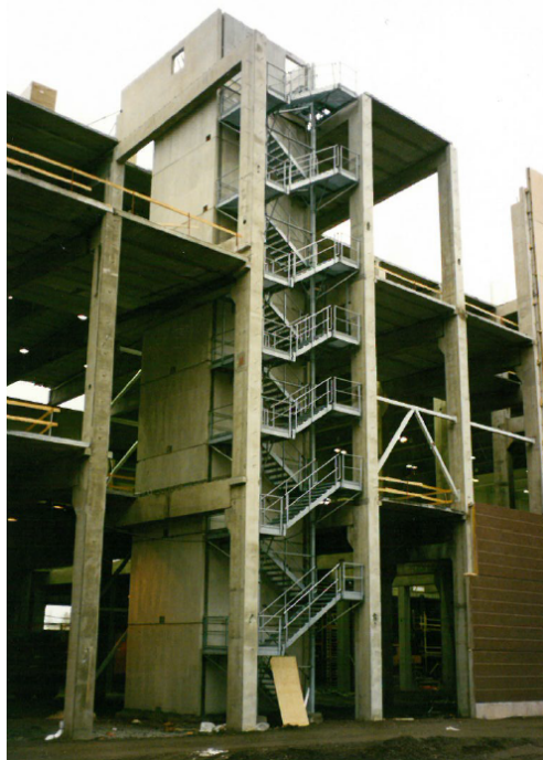
Kuva 15 Lopullinen porras asennettuna jo rakennusvaiheessa (Veijo Timonen 1995)
