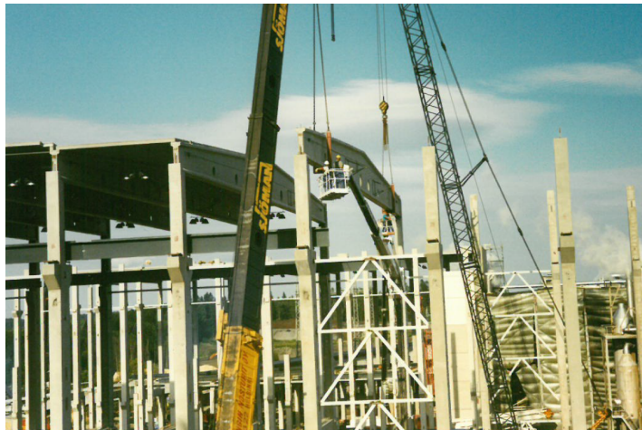
Kuva 1 Paperitehtaan rungon pystytyks on pitkälti asennustyötä (Veijo Timonen 1995)
