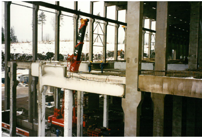
Kuva 14 Elementtirakenteisen tehtaan sisätilat saadaan nopeasti säältä suojaan (Veijo Timonen 1995)
