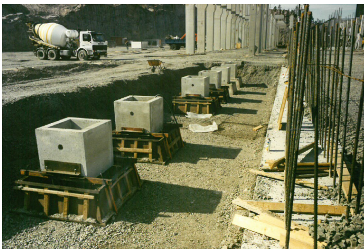
Kuva 4 Perustusrakenteita paperitehtaan työmaalla (Veijo Timonen 1995)
