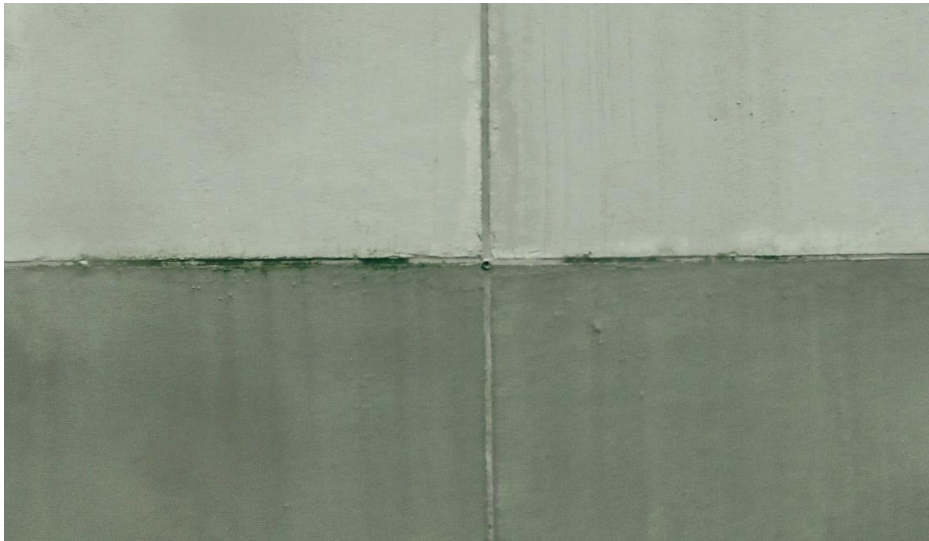
KUVA 12. Vanha elementtisauma, kuva irrotettu videokuvasta.
