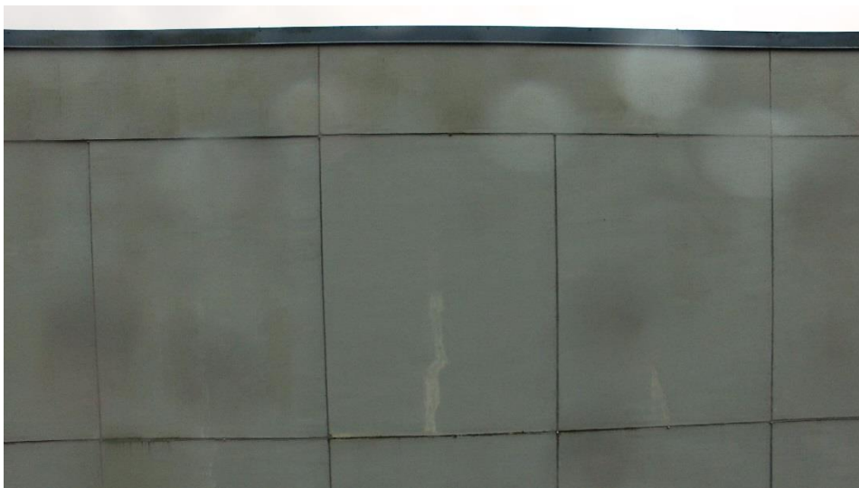
KUVA 11. Uuden maalipinnan alta esiin tulleita halkeamia, kuva irrotettu videokuvasta.
