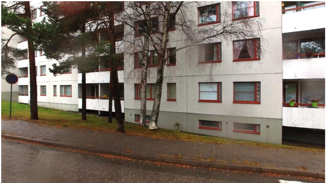
KUVA 17. Eteläjulkisivu, kuvauksen kannalta haitallisia puita.
