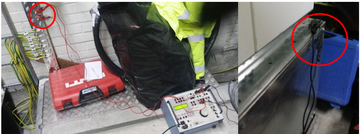
KUVA 4. Kuvasarja suojajohtimen jatkuvuuden mittaamisesta Sverkerillä.
