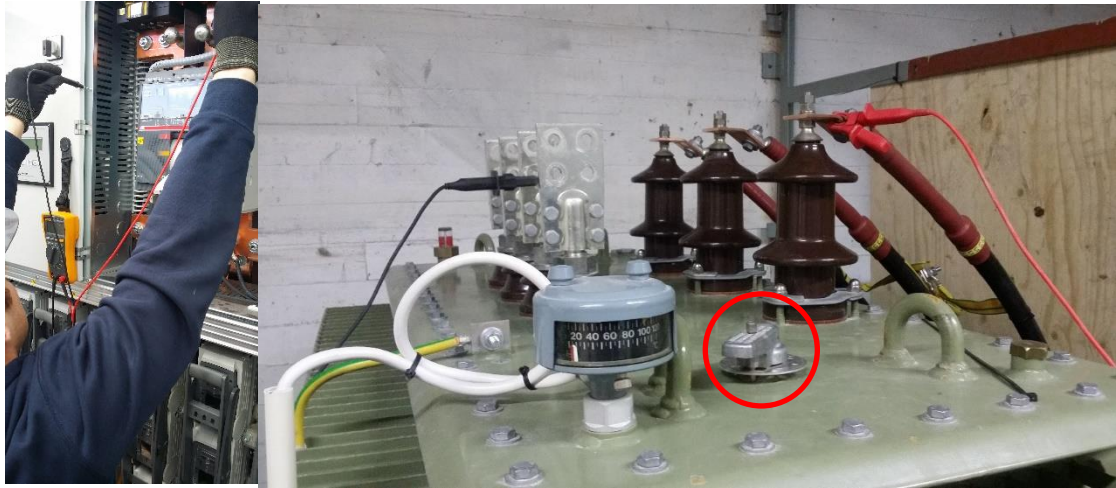
KUVA 7. Kuvasarja jännitetason tarkastamisesta.
