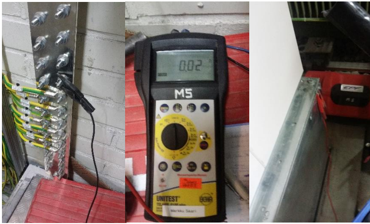
KUVA 5. Kuvasarja suojajohtimen jatkuvuuden mittaamisesta asennustesterillä.
