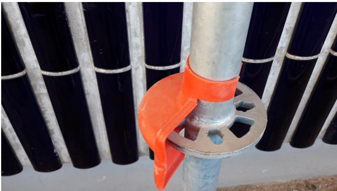
Kuva 13. Telineosien suojausta.
