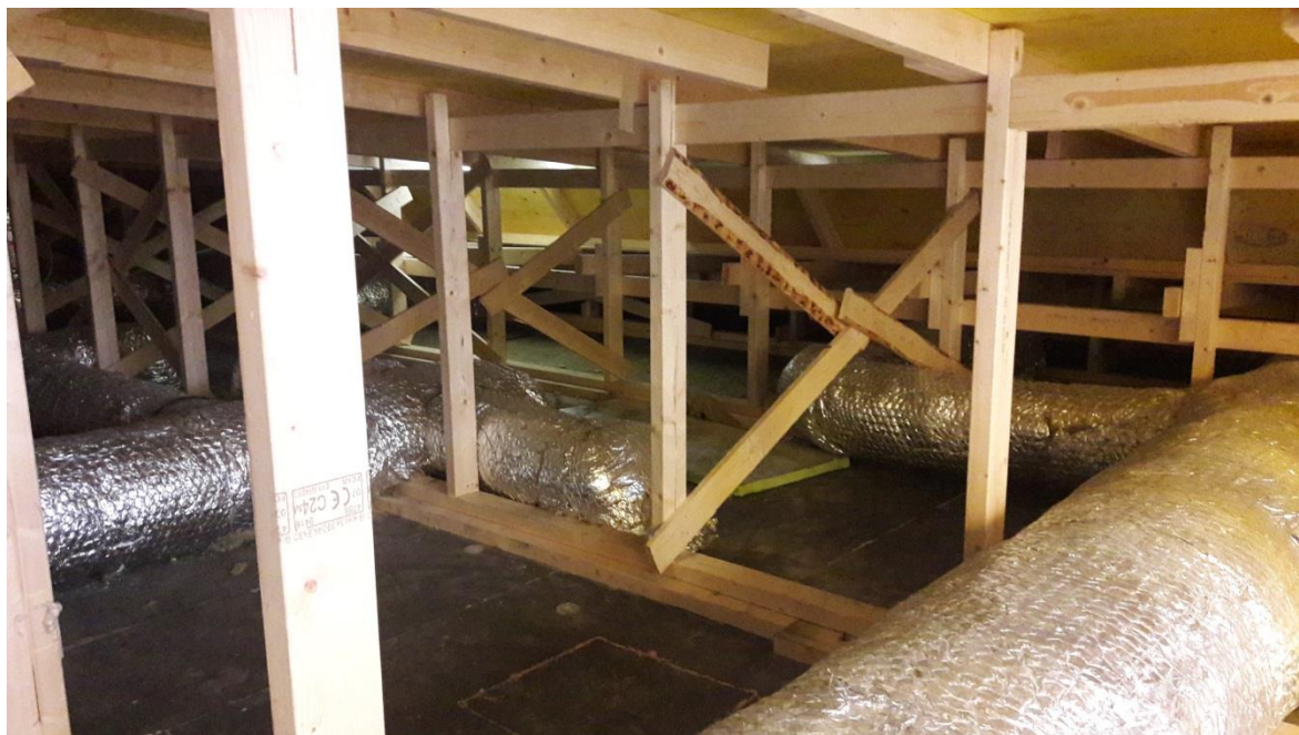
Kuva 17. Uusi kattorakenne tuulettuvassa ullakkotilassa.
