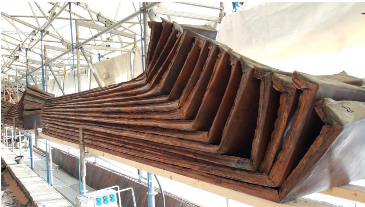
Kuva 18. Kuparilevyt numeroituna, paikkausta odottamassa.
