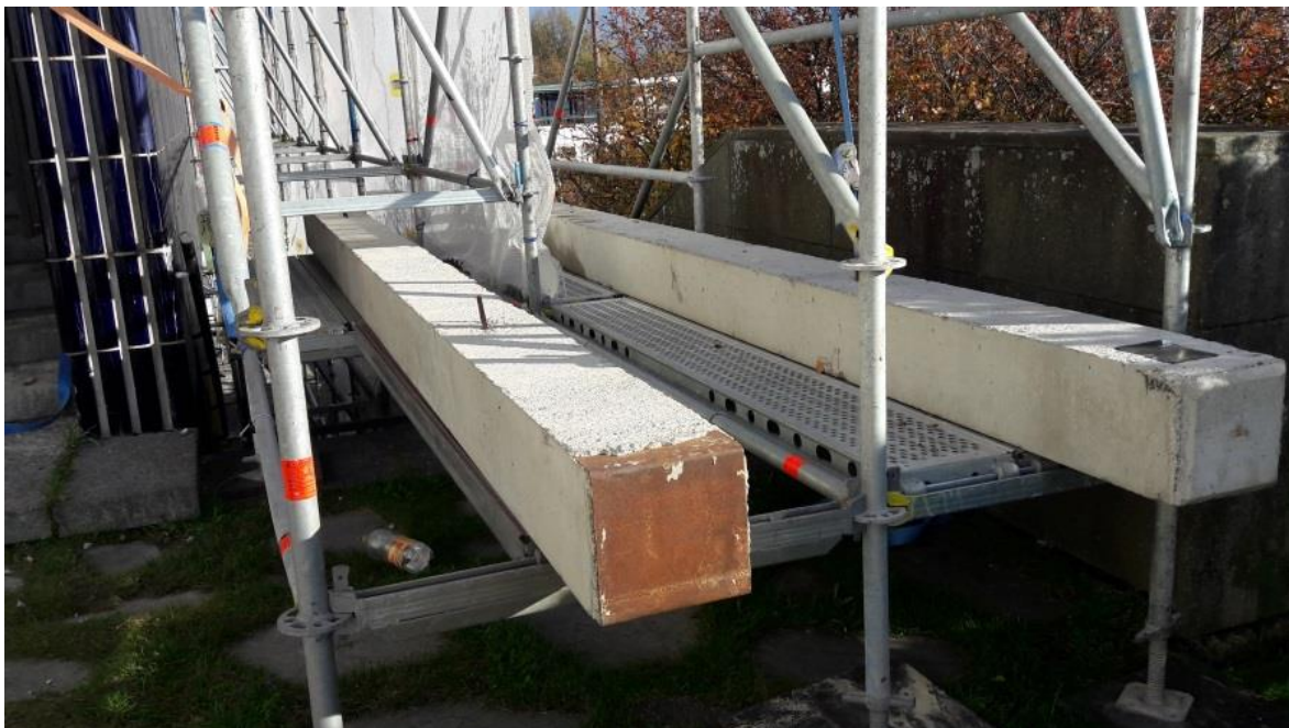
Kuva 1. Teline rungolle asetettuja vastapainoja.
