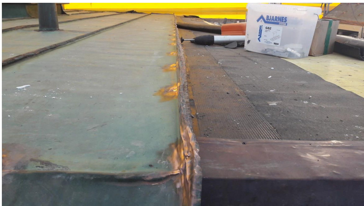
Kuva 20. Korjattua ja takaisin asennettua kuparikatetta.
