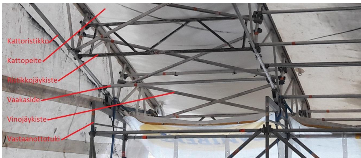
Kuva 4. Sääsuojan rakenneosia.
