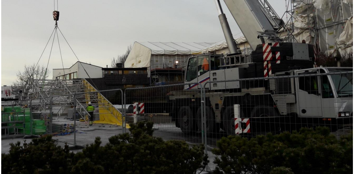
Kuva 5. Sääsuojan kattoristikot maassa.
