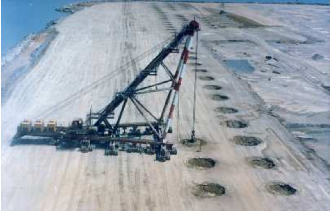
Kuva 13. Nizzan lentokentän tiivistys pudotustiivistyksenä /24/
