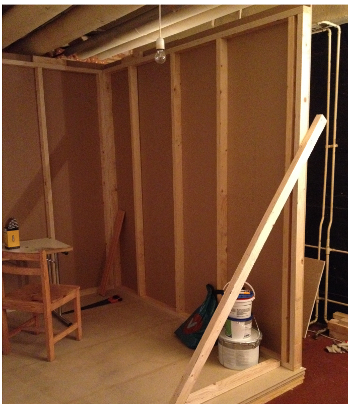
Kuva 10. Kelluvan äänitystilän seinien ulkopuolen levytys.
