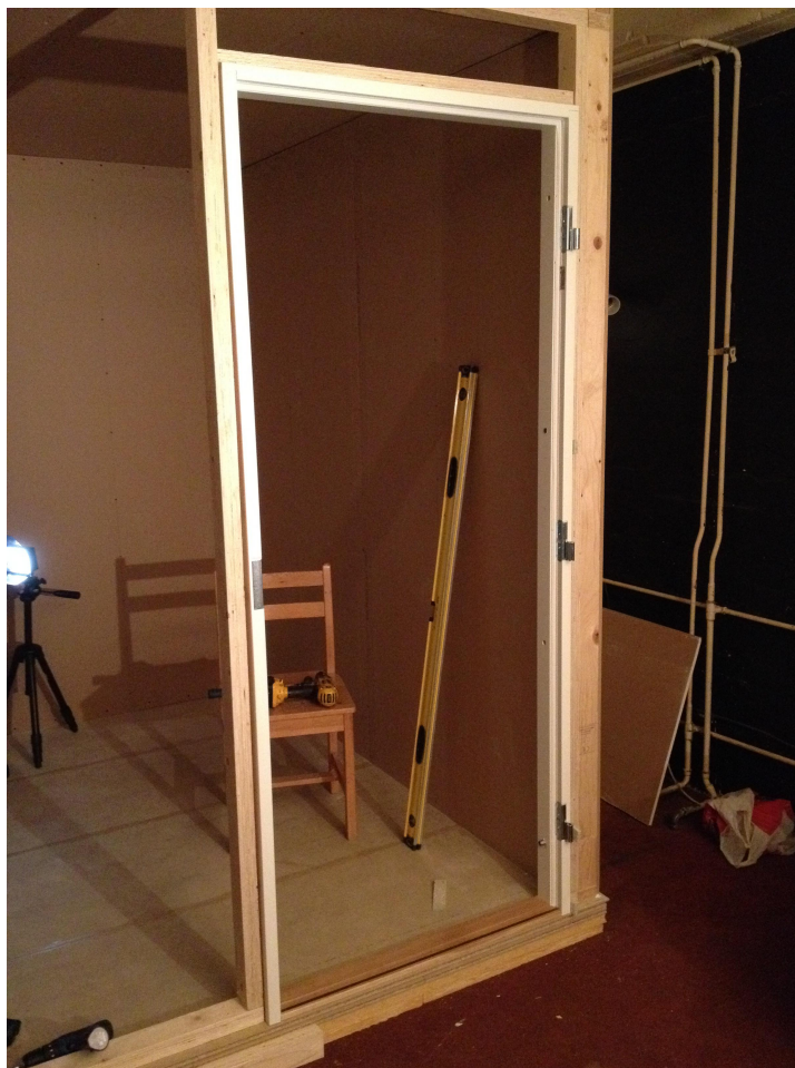
Kuva 13. Tarkkaamon ja kelluvan äänitystilan välisen oven karmien asennus
