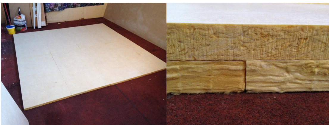
Kuvat 1 & 2. Kelluvan äänitystilän askeläänieristevillojen asennus alkuperäiseen lattiaan.
