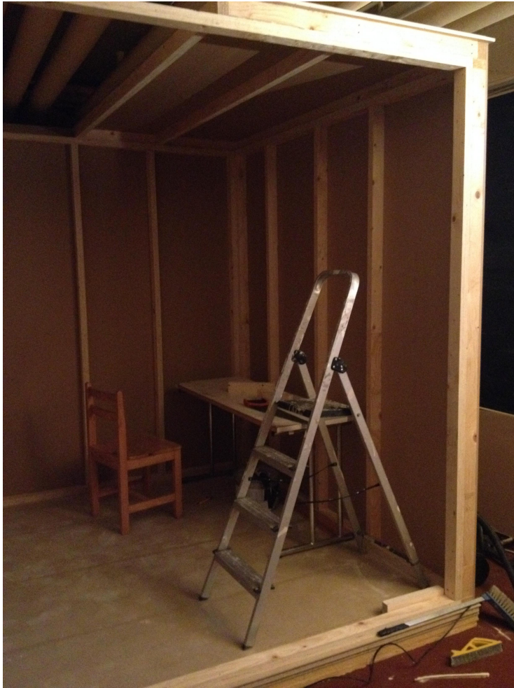
Kuva 11. Ensimmäinen kattoelementti paikoillaan.
