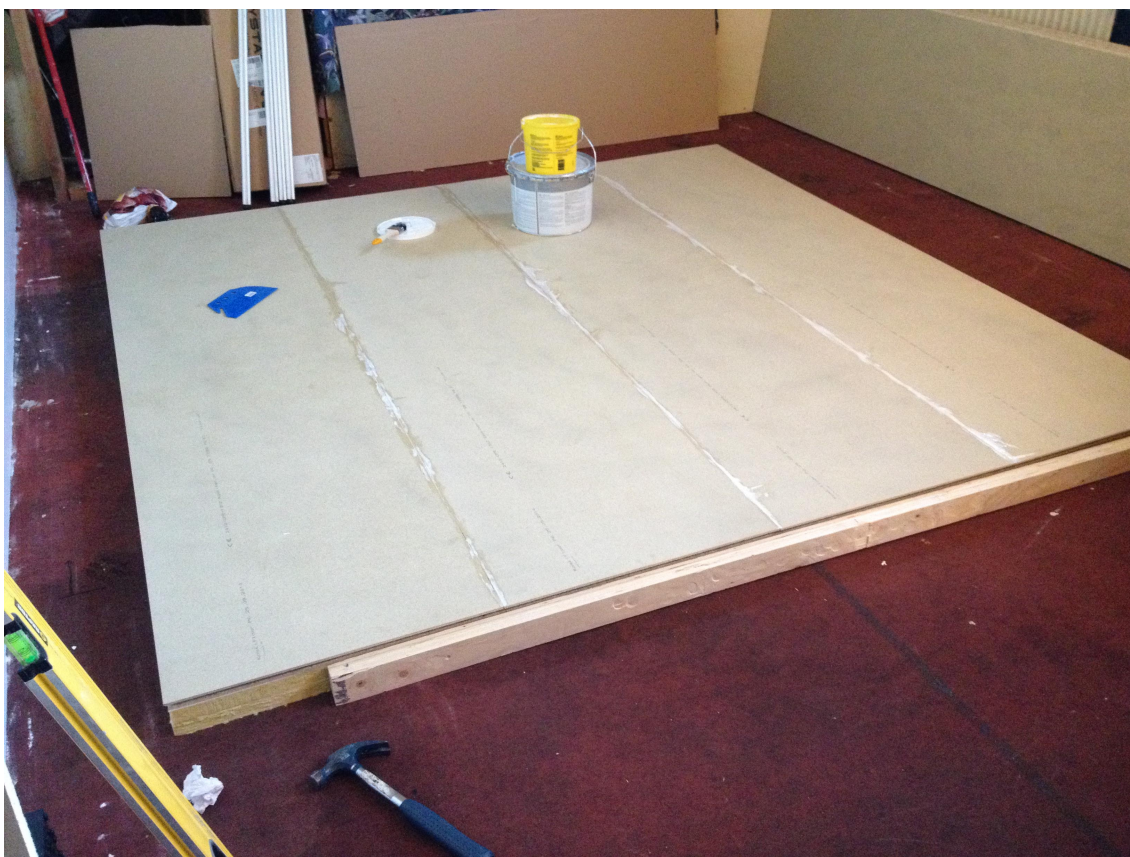
Kuva 3. Ensimmäinen lattialevykerros ja saumaus
