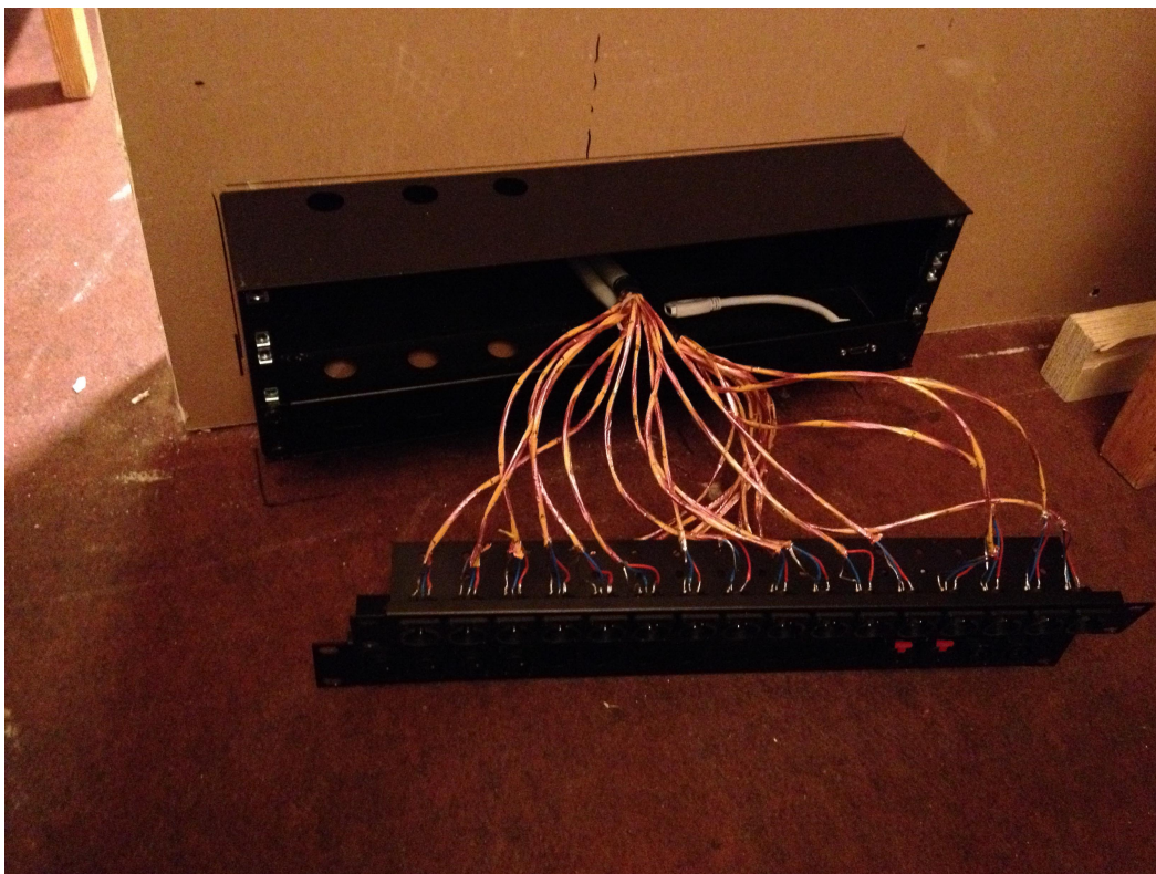
Kuva 27. Tarkkaamon ja soittotilan välisen kytkentäpaneelin kolvaus valmistunut ja seuraavaksi kiinnitys.
