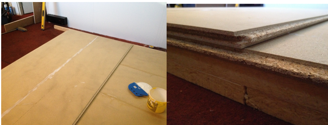
Kuvat 4 & 5. Vasemmalla toisen lattialastulevykerroksen liimaus ja oikealla askeläänieristelevyt lastulevykerroksien alla.
