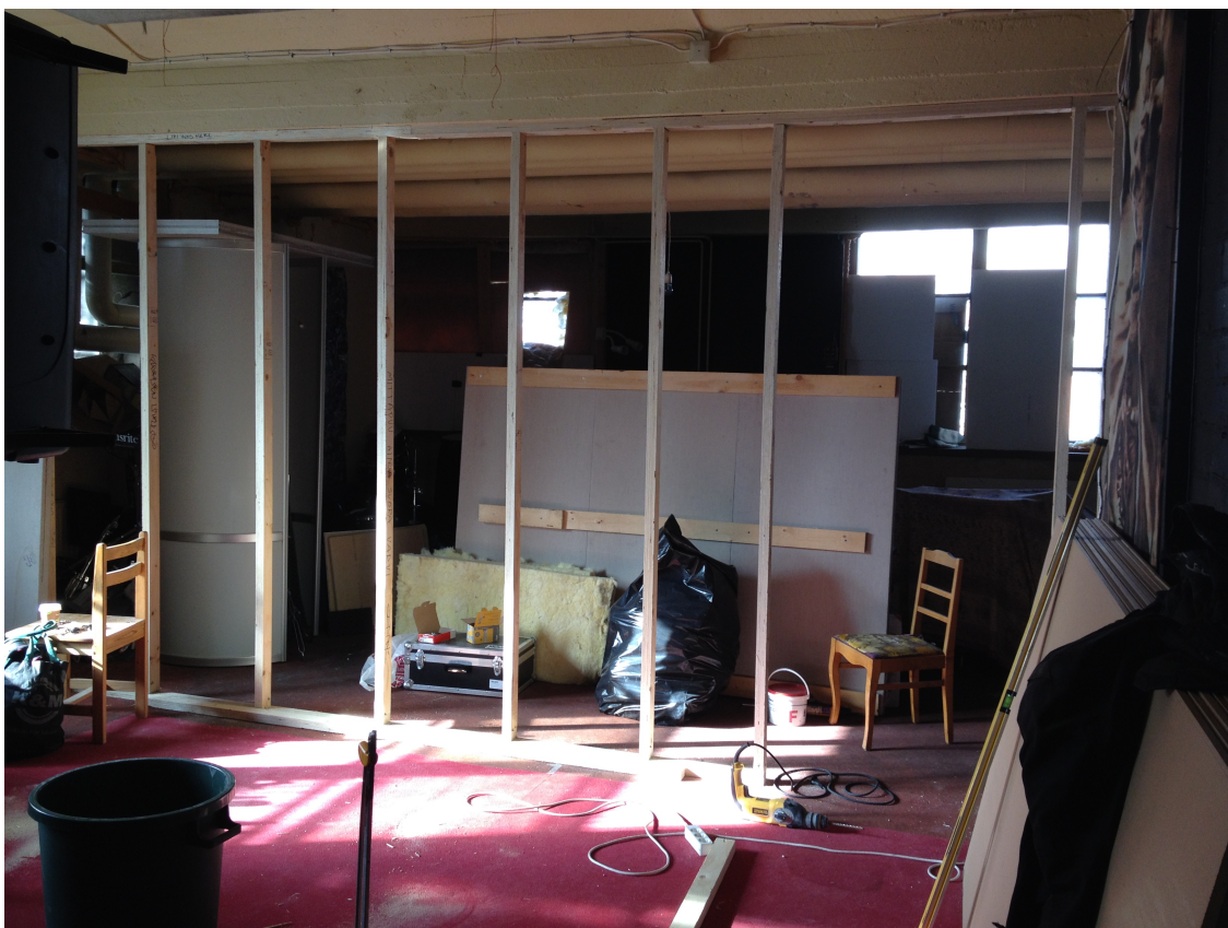
Kuva 7. Uusi runkorakenne soittotilan ja takapuolelle jäävän kelluvan tilan/ tarkkaamon väliseen seinään.
