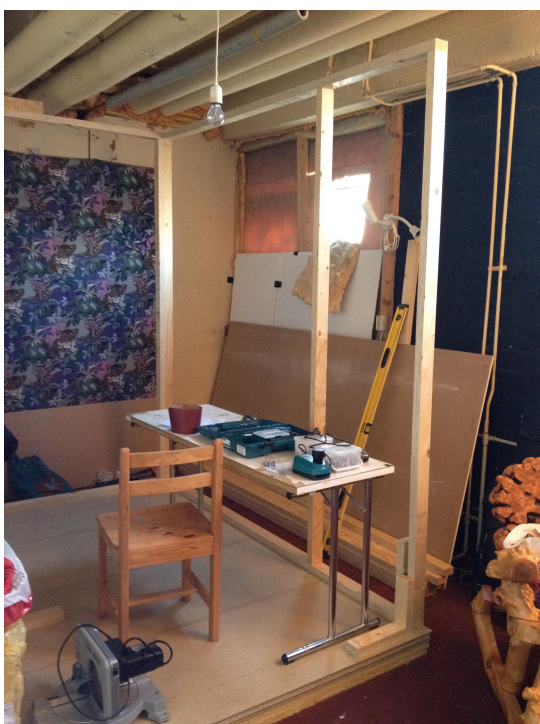
Kuva 8. Kelluvan äänitystilän seinäkoolauksien asennus.
