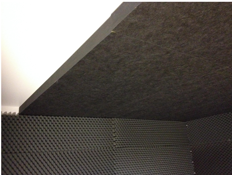
Kuva 12. Kelluvan äänitystilän alakaton lopullinen pintamateriaali on Industry Modus 50 mm akustiikkapaneeli.
