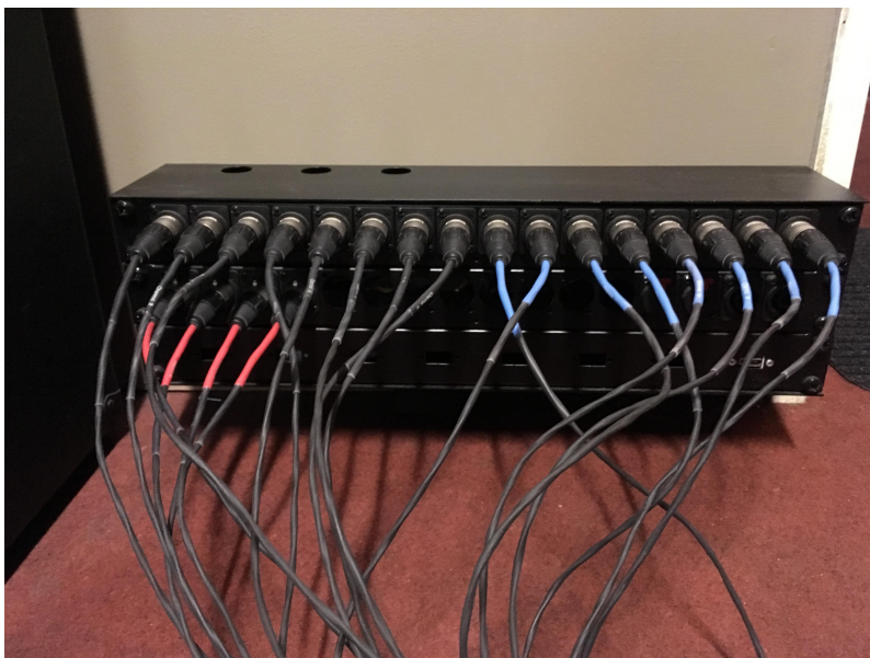
Kuva 26. Soittotilan ja tarkkaamon välinen kytkentäpaneeli 16- kanavaa sisään/ 4 ulos.
