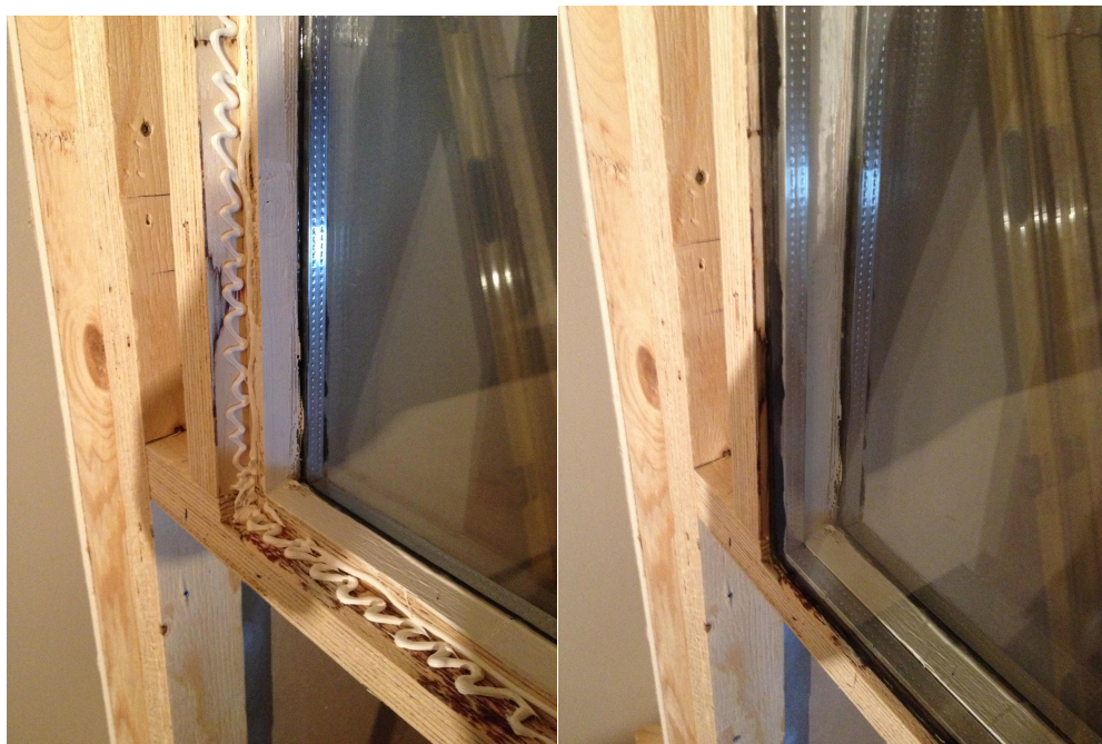
Kuvat 14 & 15. Tarkkaamon ja kelluvan äänitystilan välisen seinän ikkunalasien asennus karmeihin.
