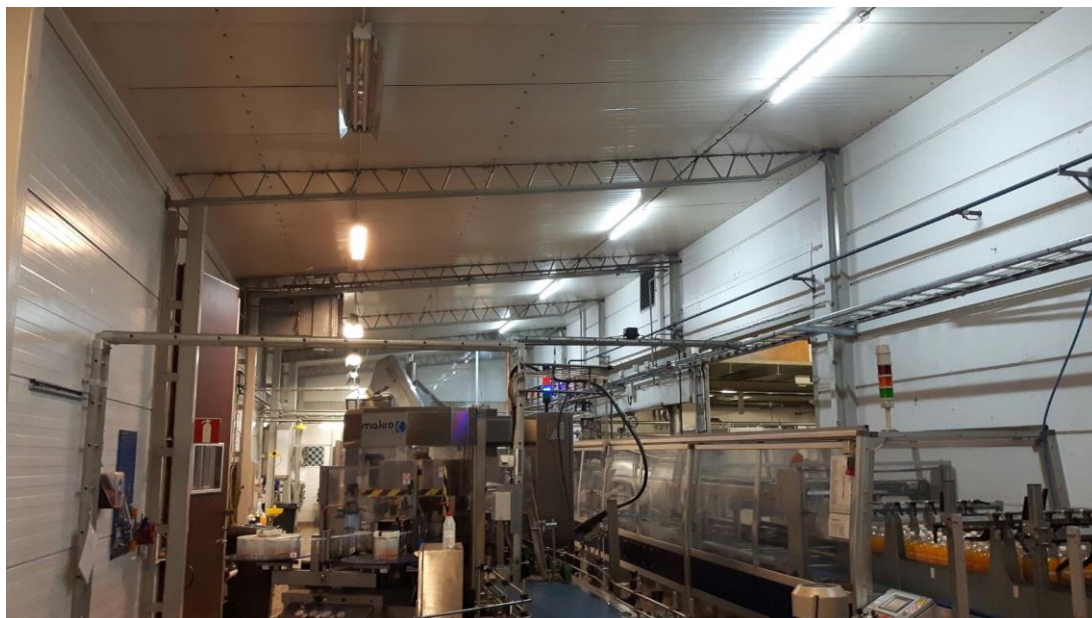
Kuva 2. Virvoitusjuomien prosessitilan loisteputkivalaisimien vaihtaminen uusiin LED-valaisimiin. (Ainasoja 2017.)
